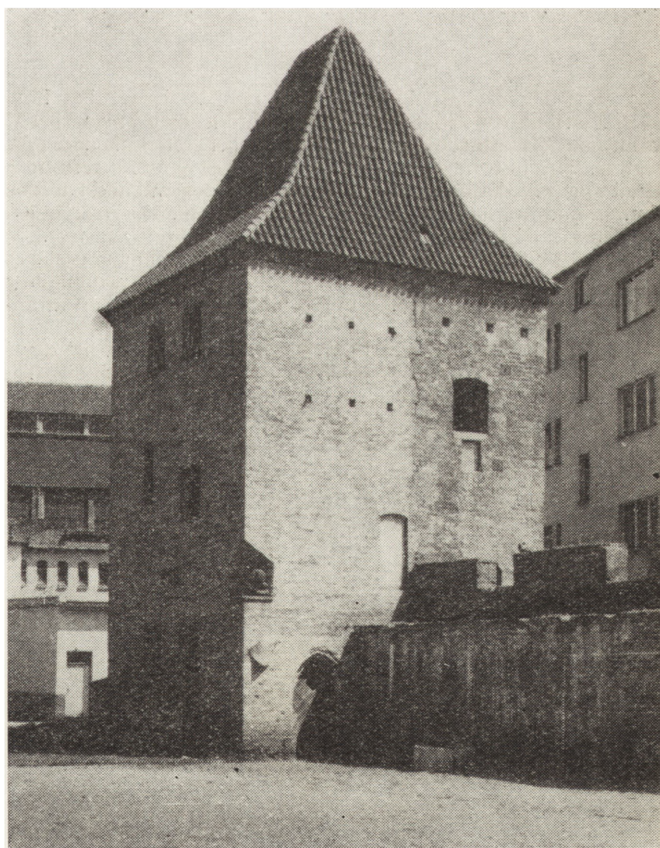
9. Wrocław, zrekonstruowana baszta trzynastowiecznych miejskich murów obronnych na tyłach pl. Nowy Targ — widoczny podział na partię autentyczną i partię odbudowaną, proj. M. Przylęcki (fot. J. Milka)
