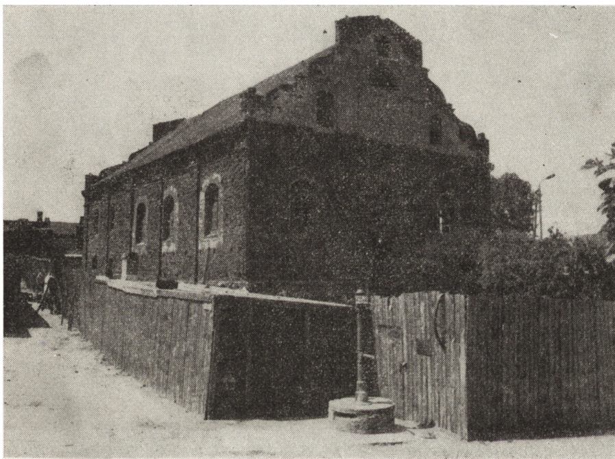
1. Lubraniec, bożnica z XVIII w. w trakcie prac remontowych
