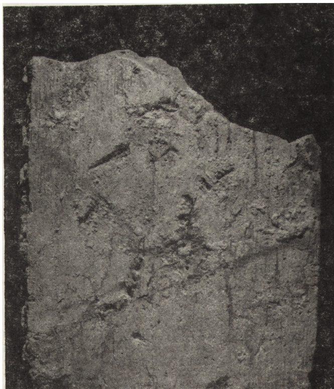
3. Przykłady powierzchni cegieł z resztkami spoiwa (fot. M. Wrzeczionkowski)
