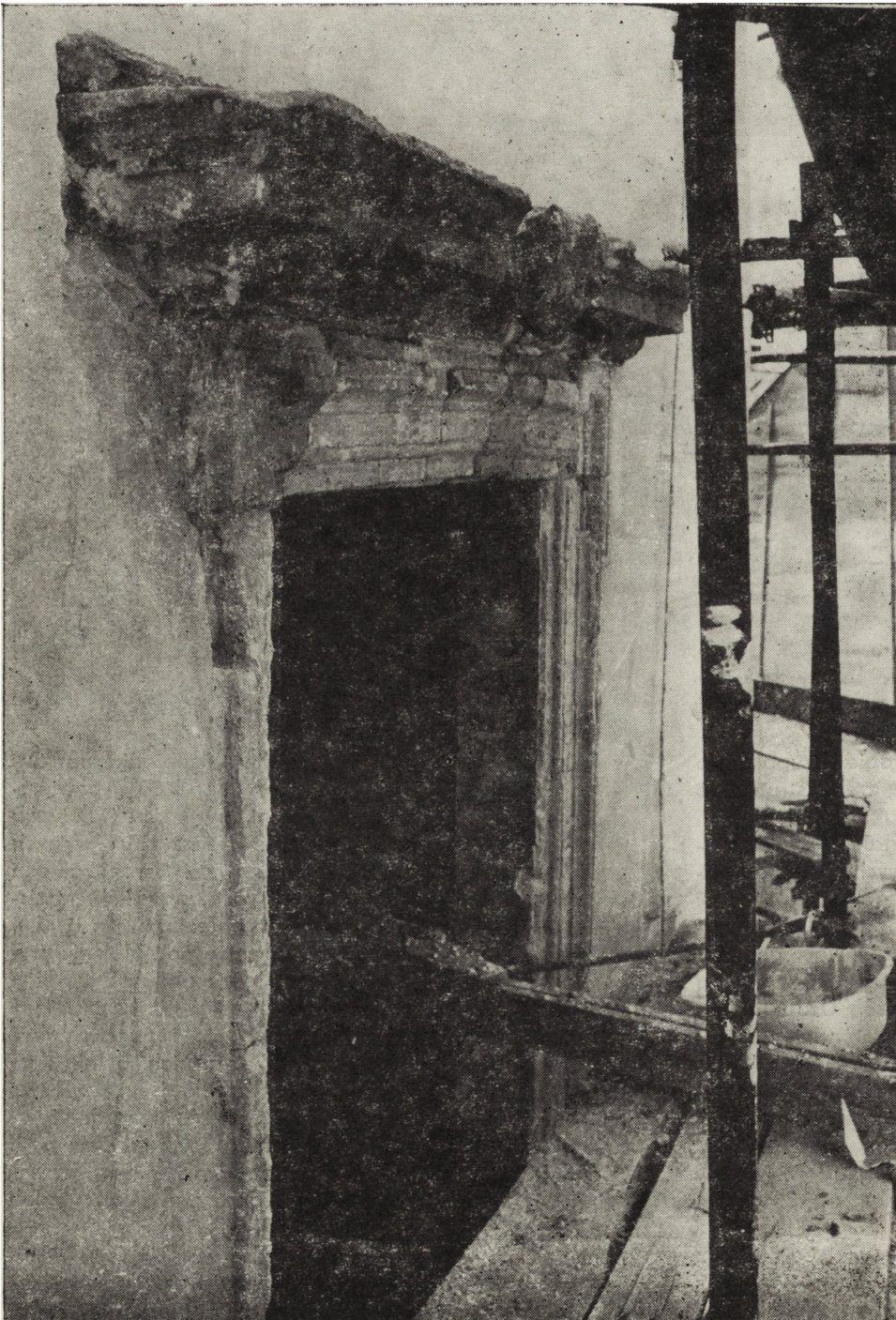
4. Kamieniarka okienna na wieży północno-wschodniej; A – stan przed konserwacją, B – stan po konserwacji
