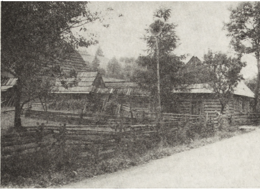
5. Ogólny widok zagrody 5. A general view of the croft
