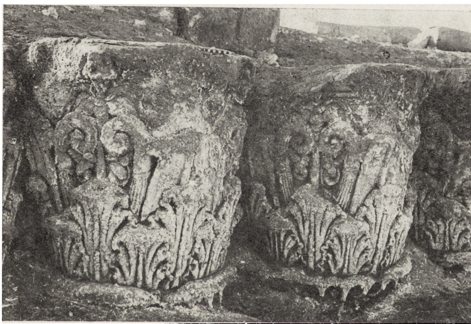
5. Bazylika – wykwit soli na kapi- telach wtórnie użytych w fundamen- tach bazyliki
