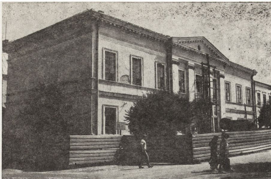
7. Przedbórz, ratusz w trakcie prac konserwatorskich (fot. W. Szygendowski, 1983 r.)
