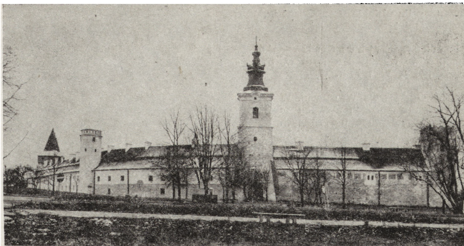
8. Sulejów, opactwo Cystersów, strona północna obwodu warownego po pracach konserwatorskich (fot. Z. Marchlewicz 1982 r.)
