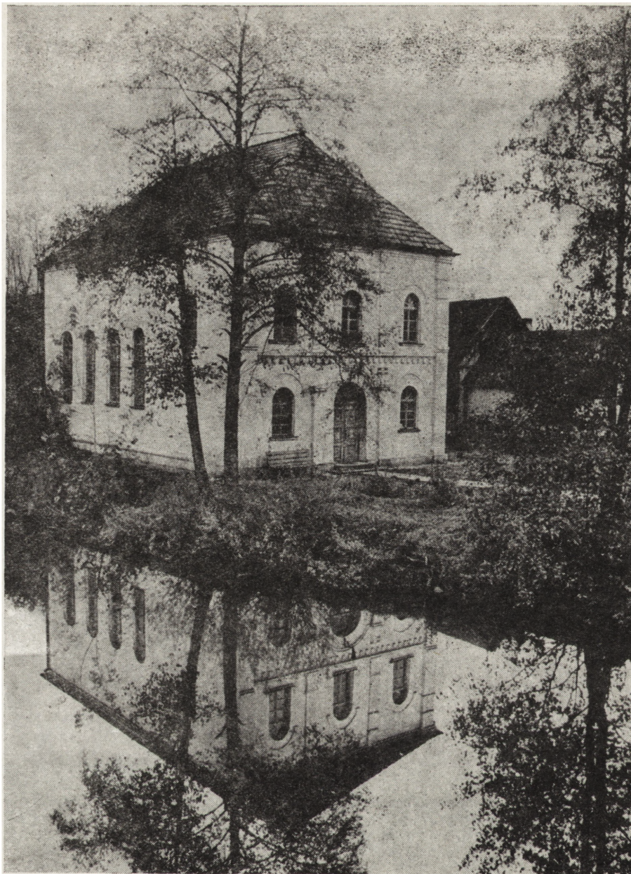
3. Inowłódz, synagoga, stan po wykonaniu robót remontowo-konserwatorskich
