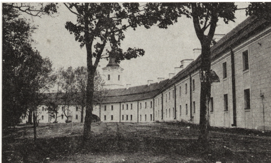
9. Sulejów, opactwo Cystersów, strona południowo-wschodnia obwodu warownego po pracach konserwatorskich (fot. Z. Marchlewicz, 1982 r.)
