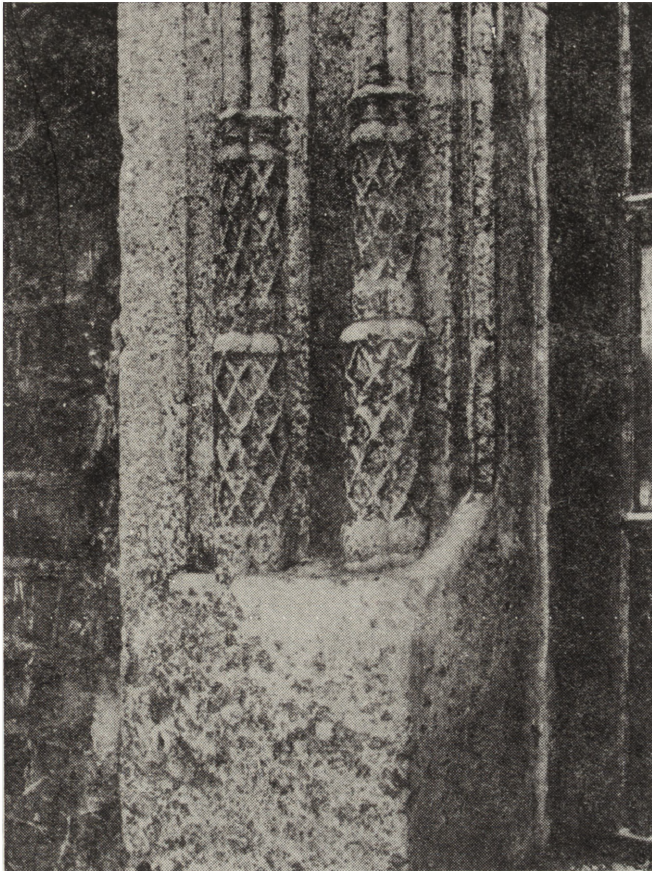
14. Piotrków Trybunalski, zamek, fragment obramienia okiennego po wstępnym oczyszczeniu
