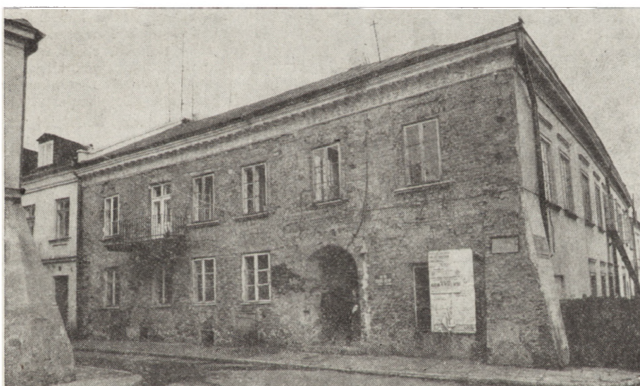
5. Piotrków Trybunalski, kamienica przy ul. Farnej 8 z XVIII/XIX w. w trakcie prac konserwatorskich (fot. T. Wilde)
