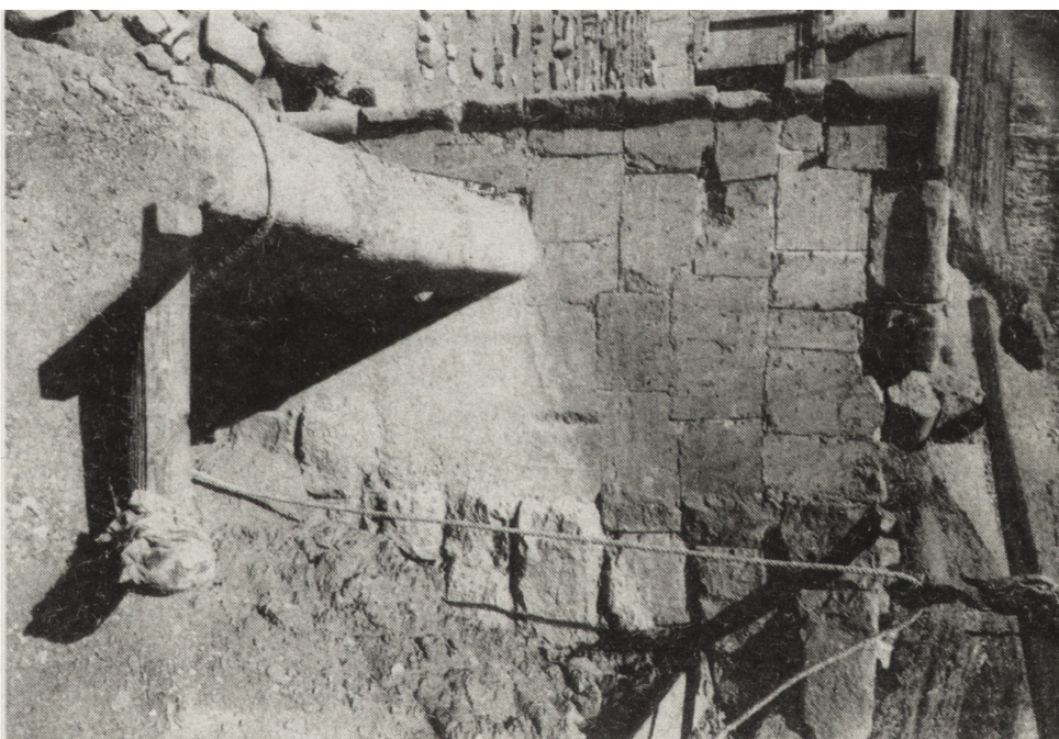
6. Widok wschodniej fasady północ- nego portyku środkowego dziedziń- ca świątyni po odsłonięciu jej frag- mentu w wykopie za murem ogra- dzeniowym. Widoczna jest zachowa- na pobiała „gesso” kryjąca spoiny układu bloków ściennych
