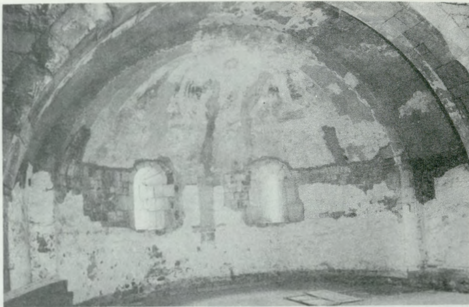
5. Malowidło romańskie — stan z 1960 r., przed konserwacją. Widoczne pionowe łaty piaskowo-cementowo-wapienne
