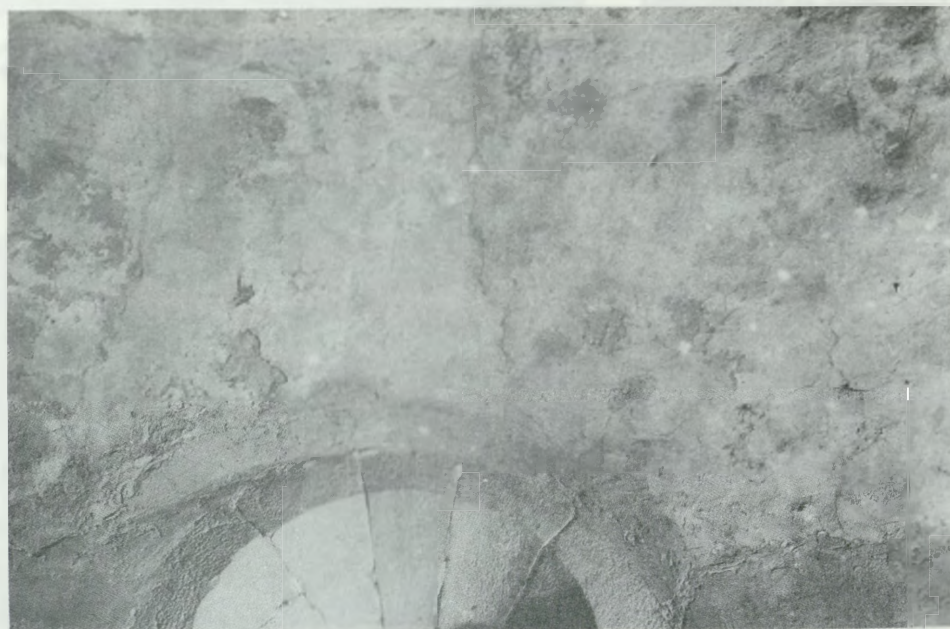
6. Fragment malowidła romańskiego — stan z 1968 r. Widoczna dezintegracja tynku i warstwy malarskiej
