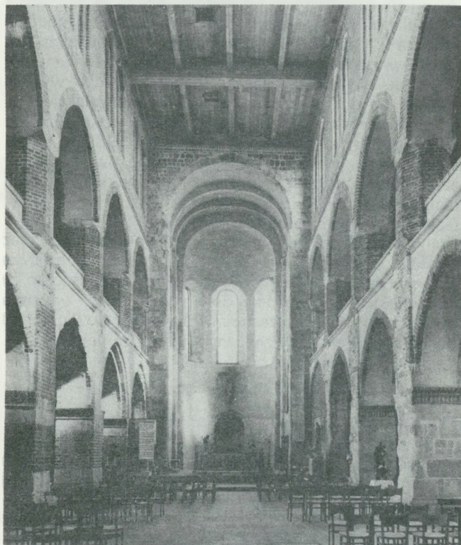
8. Widok nawy głównej w kierunku absydy wschodniej — stan z 1968 r.
