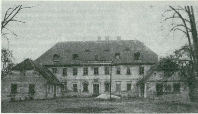
1. Biecz — pałac w trakcie remontu (fot. R. Bień)
