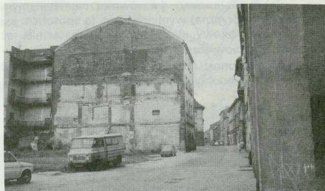
6. Sprzeczność. Stan obiektu czy zespołu stanowi inny problem, a jego wartość inny. U góry ul. Kupa (Kazimierz Krakowski), to niegdyś główny ośrodek miasta żydowskiego. W okresie powojennym ulica doprowadzona do skrajnej dewastacji. Kilkakrotnie proponowane od roku 1972 koncepcje zabudowy, zawsze przewidywały jej dowolność (czego zrealizowany fragment widać po lewej), nie biorąc pod uwagę tradycji miejsca, urbanistyki historycznej i nielicznych źle zachowanych, lecz historycznych elementów. Np. w głębi widoczna Bóżnica Kupa (XVI w.) i mur miejski (XIV w.). U dołu ul. Józefa (tamże) podobnie zniszczona. W miejscu po wyburzonych kamienicach z XVI-XVIII w. (po lewej) nie może powstać cokolwiek. W obu wypadkach nie można dopuścić do „twórczej swobody” architekta sprzecznej z krajobrazem miasta, lecz rekonstruować całość zgodnie z tradycją miejsca (fot. J. Bogdanowski)
