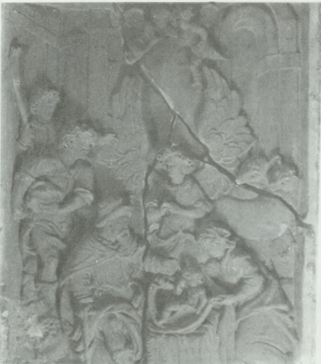
12. Plaskorzeźba z piaskowca o spoiwie ilasto-krzemionkowym przed konserwacją. Powierzchnia uszczelniona czarną „skorupą” nawarstwień, widoczne pęknięcia płyty
