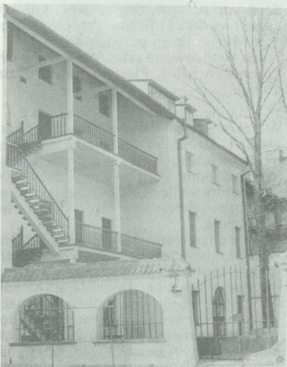
52. Lublin, kamienica, ul. Klonowica 6 – elewacja południowa (fot. J. Bożek, 1991)
