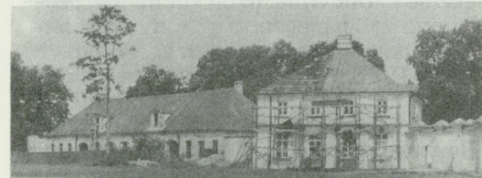
8. Kozłówka (gm. Kamionka), fragment zabudowy dziedzińca od strony północnej (fot. R. Janukowicz, 1989)
