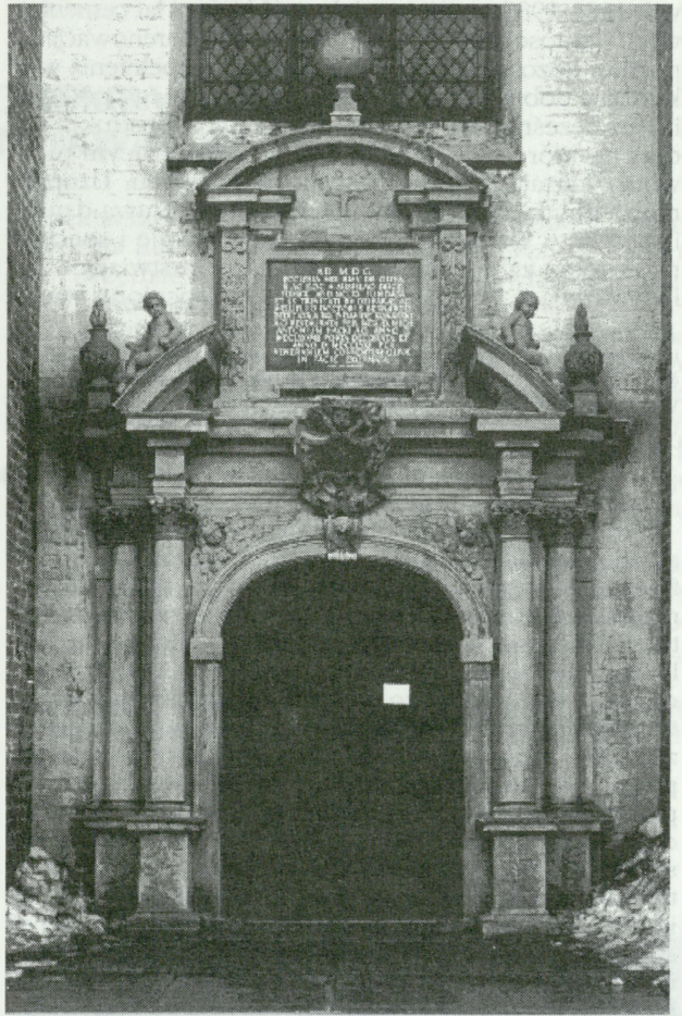
27. Portal główny, 1688 r., stan po konserwacji, kościół katedralny w Oliwie
