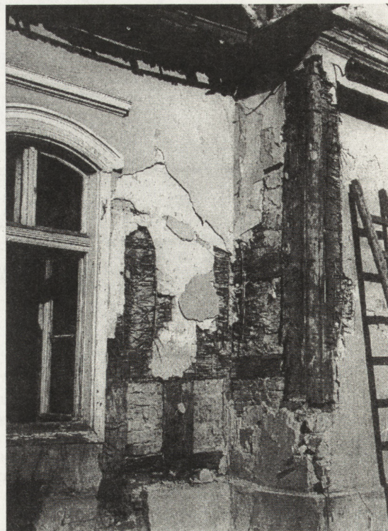
8. Fragment fasady przy alkierzu wschodnim. Widoczny skrócony narożny słup alkierza o profilowanej krawędzi, system ryglówki oraz struktura tynku
