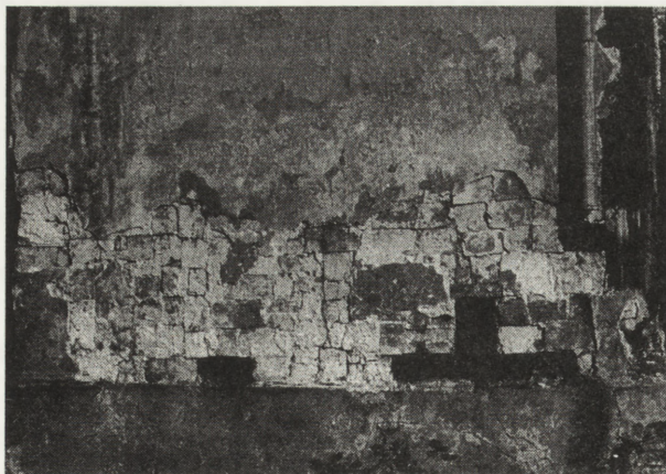
12. Zachodnia ściana alkierza zachodniego. Widoczna struktura tynku z płasko ułożonymi dachówkami, spod których, dołem, widoczne rygle i odcinki słupów
