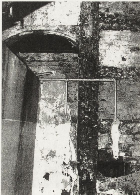
13. Fragment wschodniej elewacji ryzalitu salonu, odsłoniętej w trakcie prac inwentaryzacyjnych w przylegającej przybudówce
