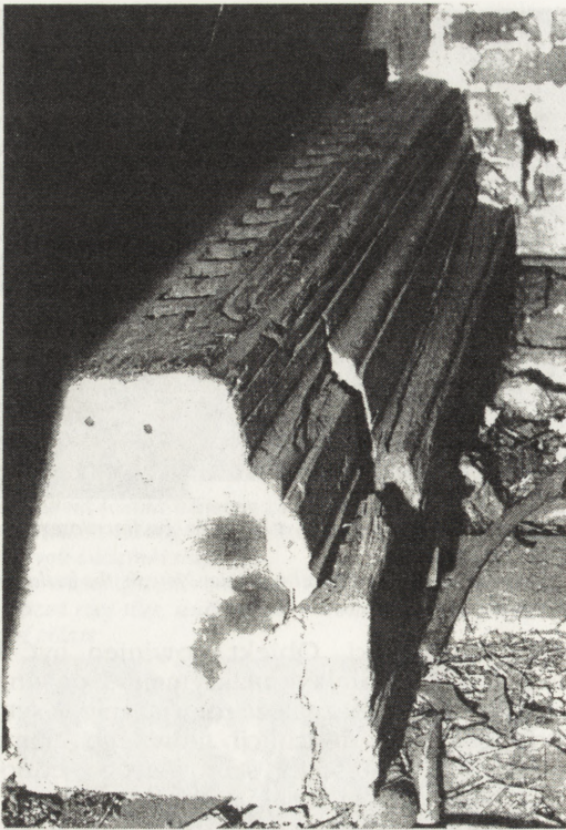
17. Fragment starego soszębu wtórnie użytego w charakterze podciagu belek stropowych nad salonem
