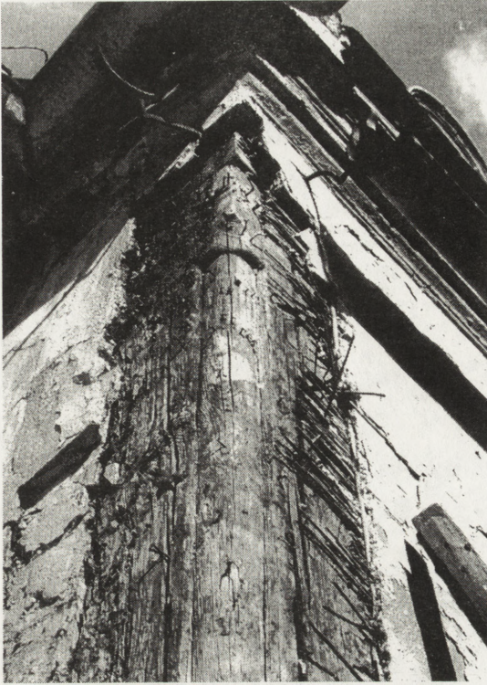
9. Fragment narożnego słupa alkierza wschodniego. Widoczny profil krawędzi 9. Fragment of corner pillar of eastern alcove. Visible profile of edge
