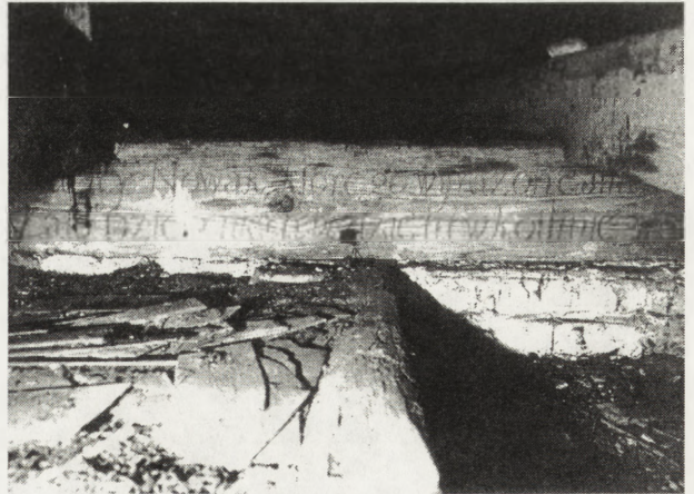
16. Fragment inskrypcji Macieya Nowaka, budowniczego dworu, na platwi na poddaszu
