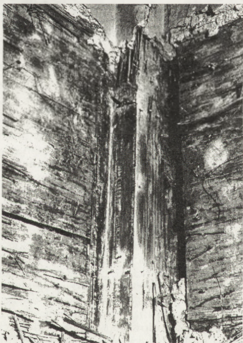
14. Narożnik wewnętrzny słupa we wschodniej ścianie dworu w styku ze ścianą poprzeczną, w pomieszczeniu drugiego traktu. Na ciemniejszej stronie słupa widnieją poziome kreski — resztki polichromii
