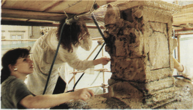
E. Brama południowa, postument środkowego wazonu wieńczącego, w trakcie prac konserwatorskich — usuwanie kor zwietrzelinowych; widoczna erozja materiału E. Southern gate; pedestal of the central crowning vase, in the course of conservation — the removal of weathering crusts; visible erosion of material
