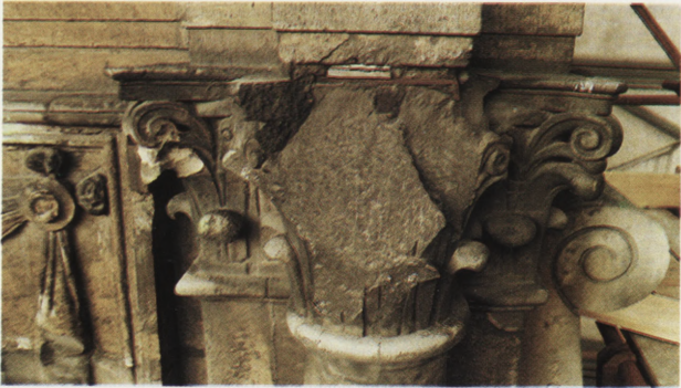
F. Brama południowa, kapitel pd-wsch., stan przed konserwacją — kory zwietrzelinowe i wielkie ubytki F. Southern gate; south-eastern capital, state prior to conservation — weathering crusts and great losses
