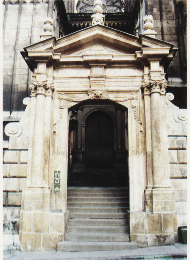
A. Brama barokowa przed wejściem głównym do Katedry Wawelskiej, stan przed konserwacją. Widoczne czarne kory zuietrzelinowe (wszystkie fot. P. Stępień)
