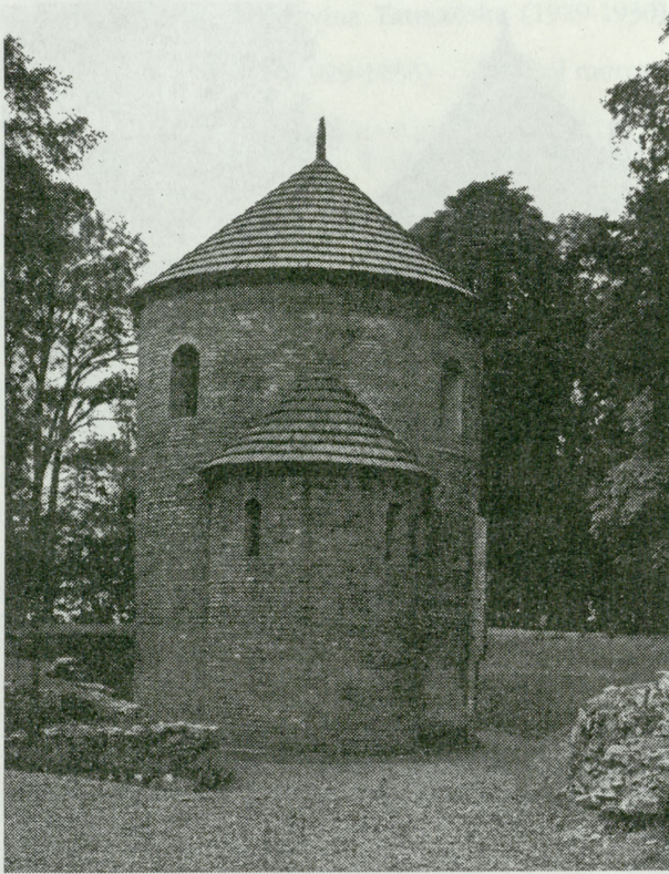
3. Oleszyn, rotunda, stan po konserwacji. Fot. T. Kaźmierski 3. Oleszyn, rotunda, state after conservation. Photo: T. Kaźmierski
