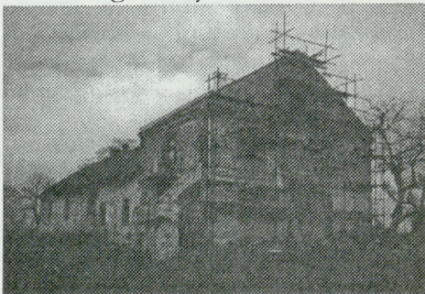
8. Kacice — dwór z XVI i XIX w. w trakcie prac remontowych. Fot. A. Siwek
