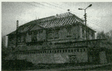
18. Wieliczka — Pałac Salinarny z XVIII w. w trakcie prac remontowych. Fot. z archiwum PSOZ Kraków
