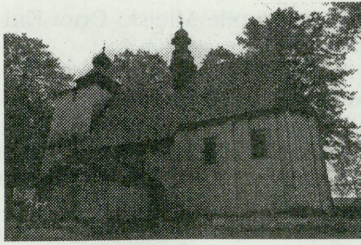
13. Paczółtowice — kościół par. Narodzenia NMP po remoncie. Fot. z archiwum PZOZ Kraków
