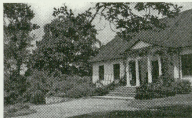
5. Gołyszyn — dwór z 2 ćw. XIX w. po pracach remontowych. Fot. Z. Bielak
