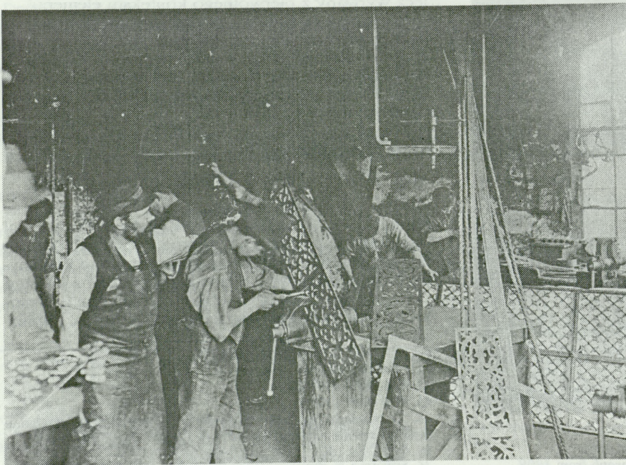
10. Wnętrze warsztatu ślusarskiego Reinholda Gutha w czasie prac nad kratką do kaplicy Św. Anny. Fot. 1901 r.
