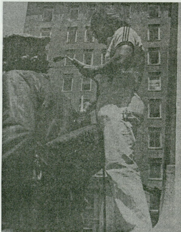
6. Nagrzewanie powierzchni zach. grupy pomnika przed woskowaniem. Fot. Dennis R. Montagna
