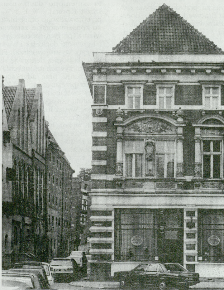
Toruń, ul. Rabsiańska 19/21 — spichrze po zakończeniu prac konserwatorskich
