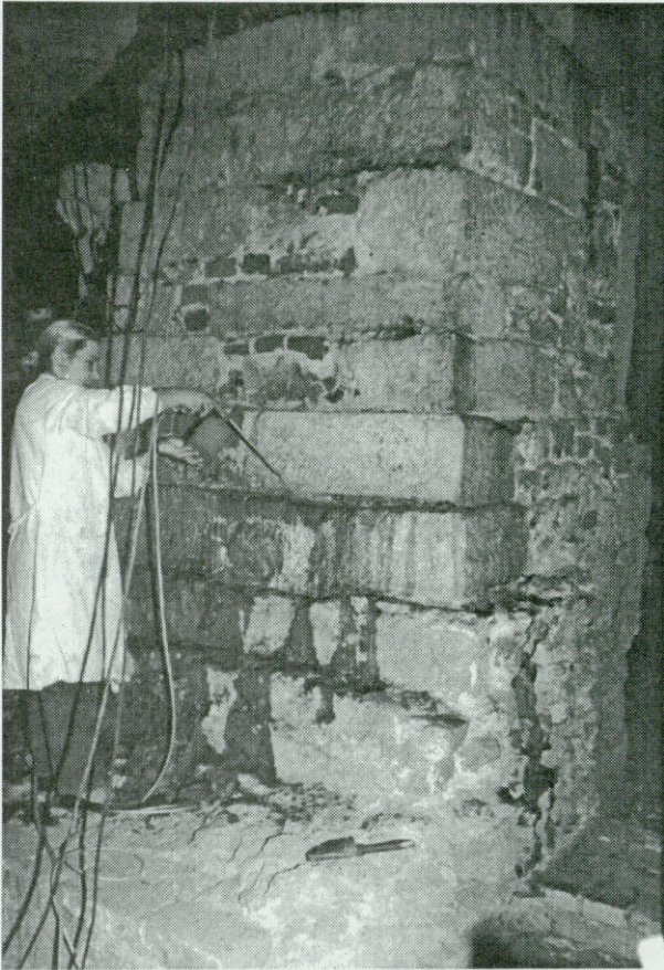
4. „Wawel Zaginiony”, prace przy jednym z filarów kuchni renesansowej, 1994. Fot. P. Stępień 4. The „Lost Wawel”, the conservation of a pillar of the Renaissance kitchen, 1994. Photo: P. Stępień
