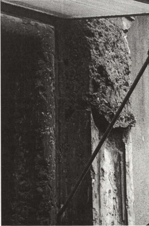
2. Destrukcja wapienia dębnickiego w formie soczewkowatych odszczybień na fragmencie portalu na zewnętrznej ścianie kościoła św. Ducha w Toruniu
