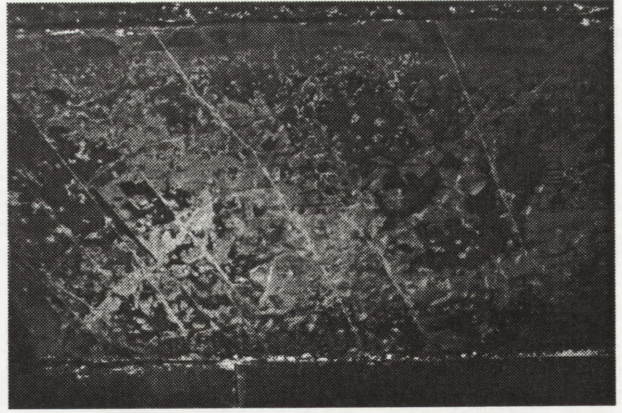
3. Płyta kamienna ze strukturą sedimentacyjną o laminacji gruzelkowej poddana procesom niszczenia, Mauzoleum Anny Wazówny w kościele NMP w Toruniu
