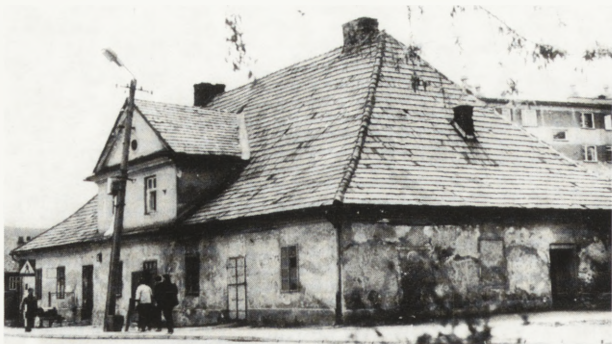
2. Wschodnia i północna elewacja dworu — stan z 1986 r. Fot. P. Kotucha
