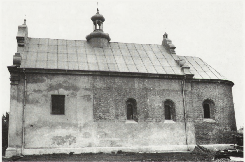
Luboml, Wołyń. Kościół parafialny (1412), wielokrotnie przekształcany; po 1946 użytkowany jako magazyn nawozów sztucznych, odzyskany 1992, w trakcie odbudowy. Fot. R. Brykowski 1993
