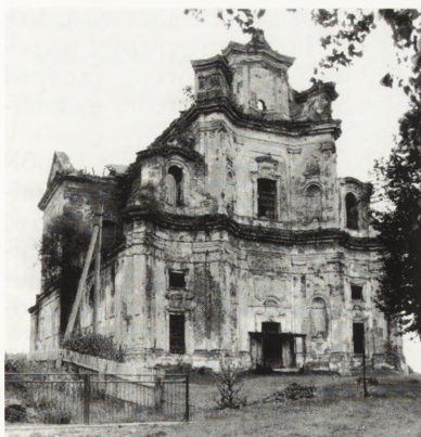
Czartorysk, Wołyń. Kościół podominikański (1741) proj. Pawła Giżyckiego; 1831 przejęty na cerkiew prawosławną; uszkodzony 1915–1920 w czasie działań wojennych, rewindykowany 1920, odbudowany 1929–1932; po 1945 opuszczony i zrujnowany; w 1995 przekazany Cerkwi Prawosławnej. Fot. G. Ruszczyk 1993
