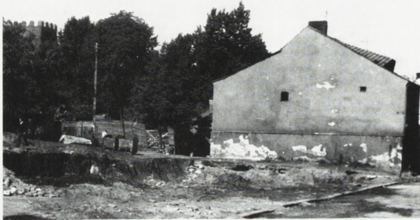
1. Wykop w miejscu rozebranych domów przy ul. Daszyńskiego, w głębi czekający na rozbiórkę dom nr 14, w którego fundamentach tkwi jeszcze nie odkryty skarb. Fot. 1985 r.
