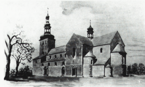
4. Widok kościoła od strony południowo-wschodniej, stan sprzed restauracji
