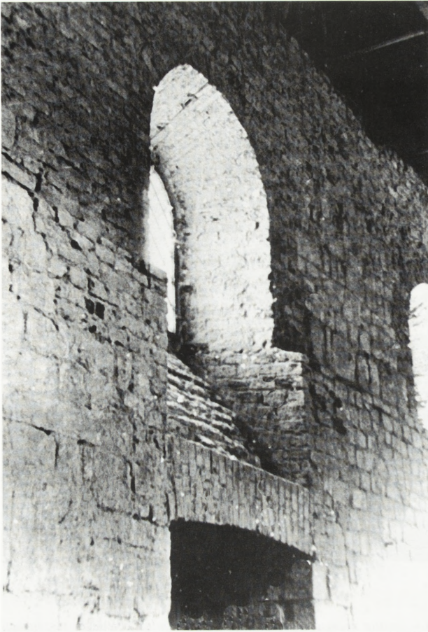
15. Wygląd archiwolty portalu południowego i okna przemurowanego w cegle (XIX w.) po skuciu tynków w latach 1954–1956
