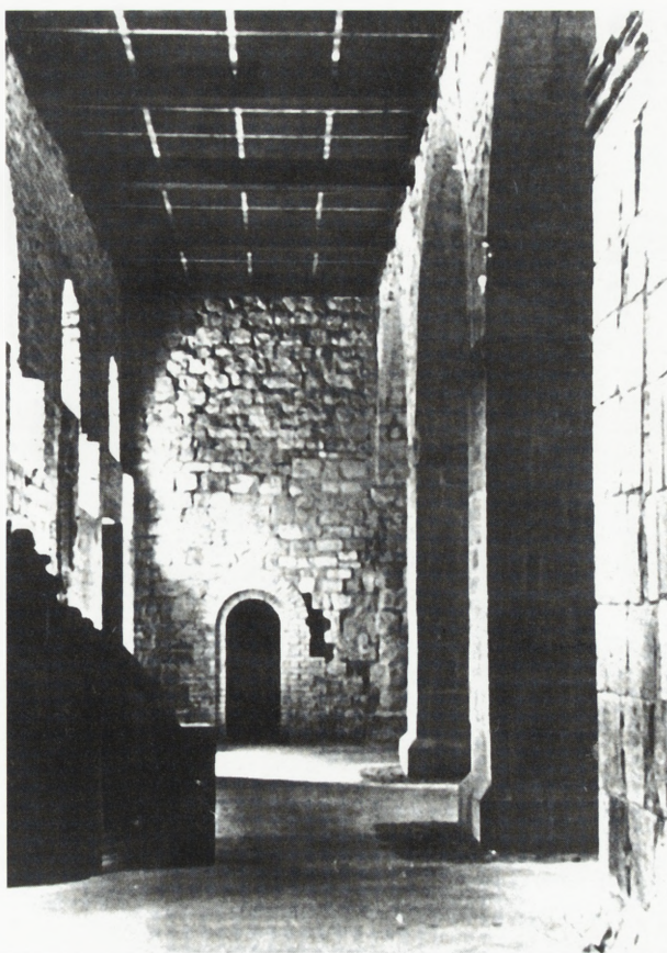
14. Ściana masywu zachodniego po odsłonięciu podczas restauracji w latach 1954–1956
