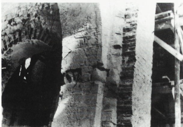
13. Południowy filar łuku tęczowego podczas prac konserwatorskich w latach 1954–1956, widoczne omurowanie cegłą (XIX w.) i zniszczenie gzymsu
