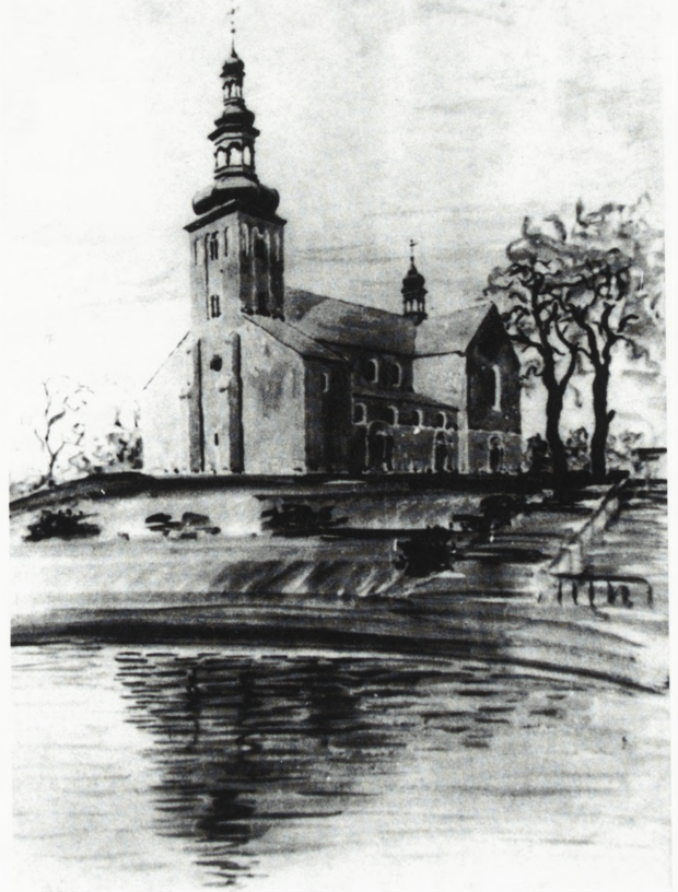
3. Widok kościoła od strony południowo-zachodniej, stan sprzed restauracji
