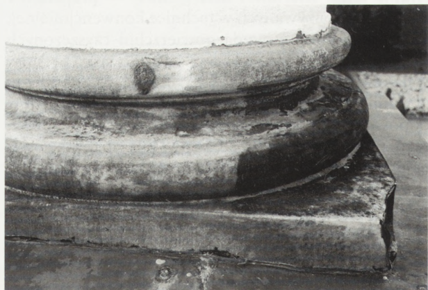
4. Fragment powierzchni kamiennej podstawy pod kolumnę oczyszczonej dwiema metodami: wstępnie — laserową, a następnie metodą „kärcher”
