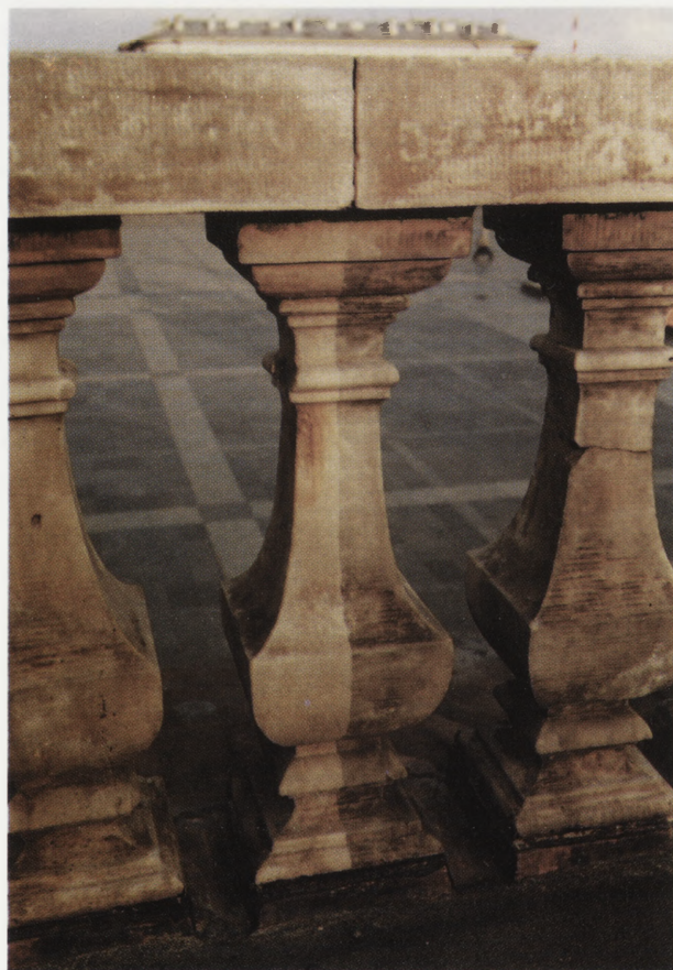
6. Powierzchnia kamiennej tralki po oczyszczeniu: jej prawa część czyszczona metodą chemiczną, a lewa część — doczyszczona laserem
