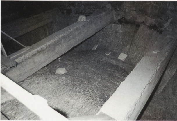
1. Archikolegiata w Tumie pod Łęczycą. Doraźna izolacja termiczna konchy z malowidłem romańskim wykonana z mat słomianych po usunięciu czapy betonowej. Fot. R. Stasiuk, grudzień 1998 r.
