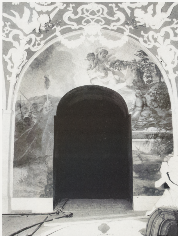
2. Poznań. Kościół oo. jezuitów, obecnie farny. Kaplica Matki Boskiej Nieustającej Pomocy, fragment ściany wschodniej, po konserwacji. Fot. K. Powidzki
