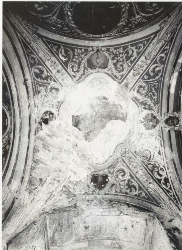
4. Poznań. Kościół oo. jezuitów, obecnie farny. Empora zachodnia, sklepienie południowe, stan przed konserwacją. Fot. J. Miecznikowski
