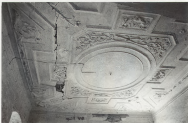
13. Strop w gabinecie gospodarza, w narożniku północno-zachodnim parteru
