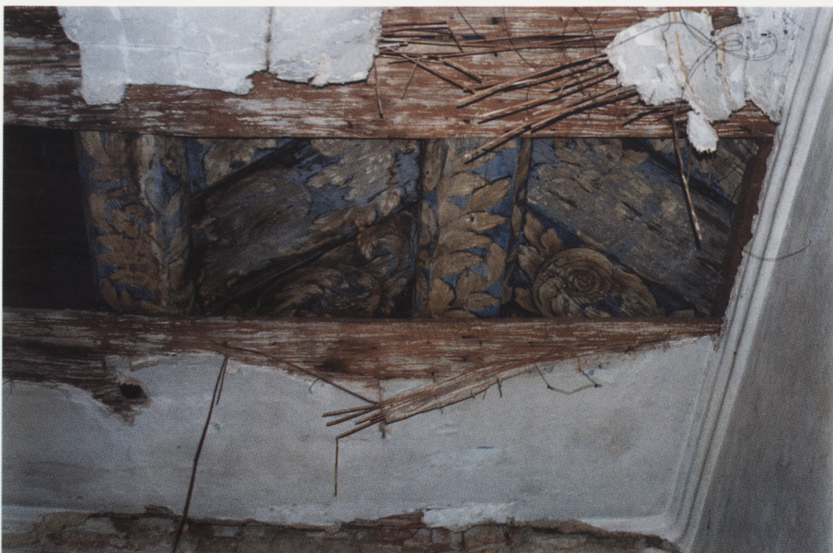
7. Fragment stropu w pokoju południowo-wschodnim na piętrze 7. Fragment of the ceiling in the south-eastern room on the storey
