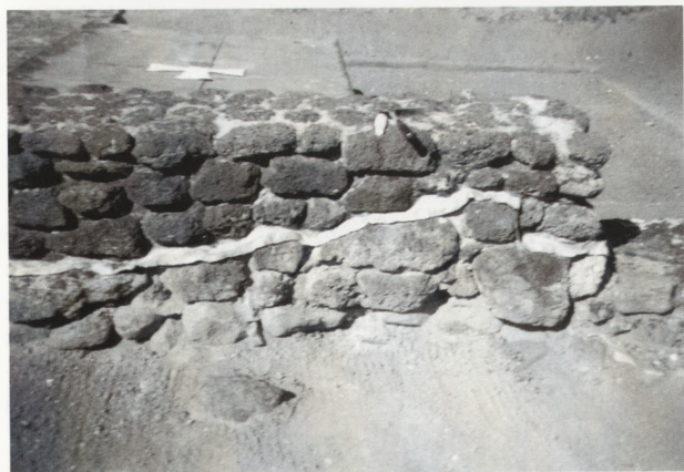
2. Odsłonięte fragmenty kościoła grodowego na Ostrowie Lednickim zbudowane z rudy darniowej. Fot. J. Skoczylas
