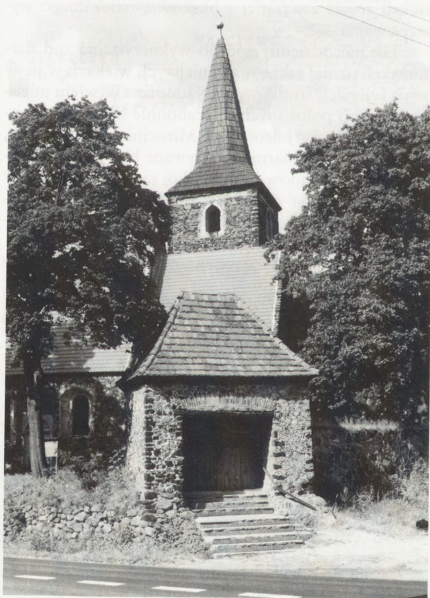
5. Niwiska. Kościół gotycki z XIII w., murowany z rudy darniowej i głazów narzutowych. Fot. D. Kuchmistrz
