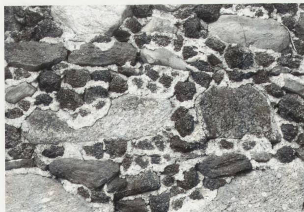
4. Lutynka. Sposób ułożenia rudy darniowej i glazów w ścianie kościoła. Fot. D. Kuchmistrz
