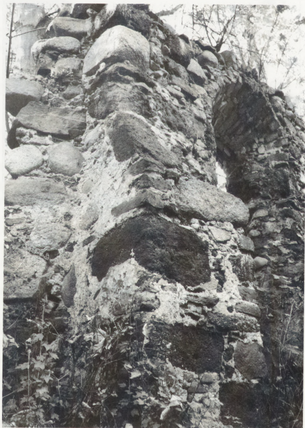
6. Zatonie. Ruina kościoła z 2 poł. XIII w. z rudą darniową jako elementem materiału budowlanego. Fot. D. Kuchmistrz
