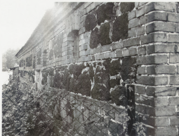
7. Zatonie. Mur z cegły i rudy darniowej z XIX w. otaczający ruiny kościoła. Fot. D. Kuchmistrz
