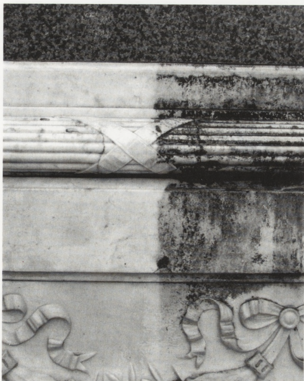
8c. Brunatnoszare przebarwienia na powierzchni płaskorzeźbionej płyciny — pozostałości zwięzłej żywicy B-72 i mikroorganizmów po oczyszczeniu, strona północna — zbliżenie. Fot. W. Procyk
