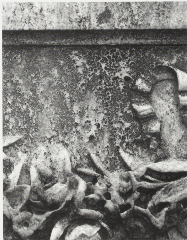
8b. Zmiany estetyczne na powierzchni płaskorzeźbionej płyciny wywołane utratą szczelności powłoki zabezpieczającej z roztworu żywicy B-72 i gwałtownym przyrostem kolonii mikroorganizmów, strona północna, zbliżenie. Fot. W. Procyk
