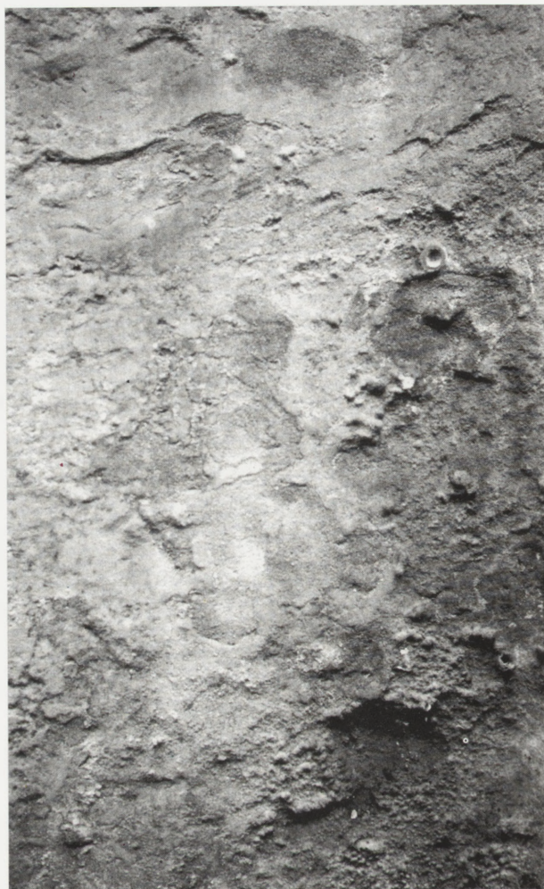
5b. Zmiany estetyczne na jednej ze ścian pomnika wywołane procesem tworzenia się nawarstwień pod szczelną powłoką „epidermy” przesączonej roztworem żywicy E-5, strona południowa — zbliżenie. Fot. W. Procyk
