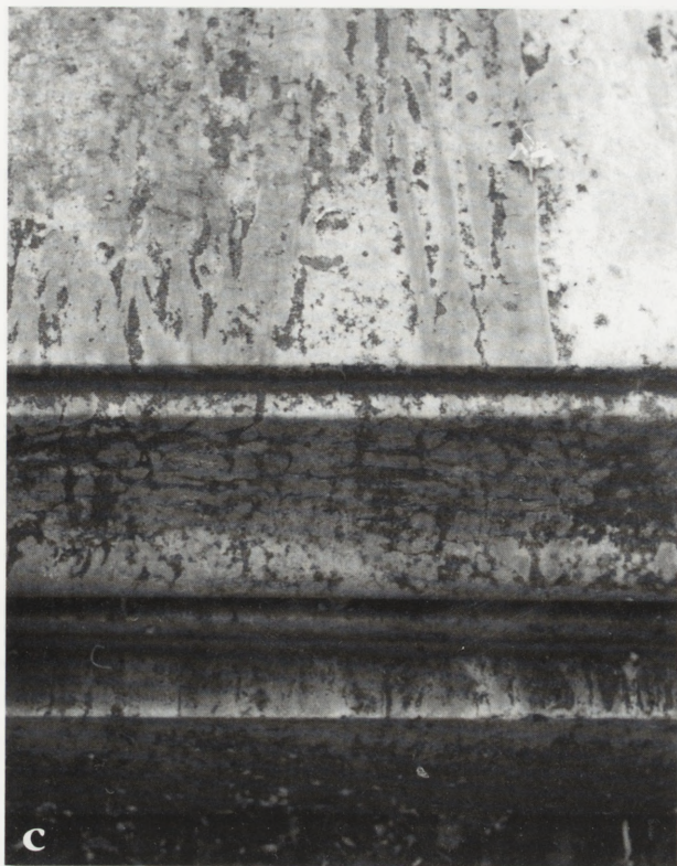
9c i d. Pomnik nagrobny rodziny Nesselrode. Ogniska dezintegracji granularnej na poziomej płycie pod powłoką z żywicy B-72 w skali „makro”, z lewej — fot. W. Procyk; z prawej — SEM, próbka 7b, powiększenie 150x, początkowa faza dezintegracji kryształów kalcytu w strefie przypowierzchniowej popiersia, fot. „mikro” R. Kopczyński
