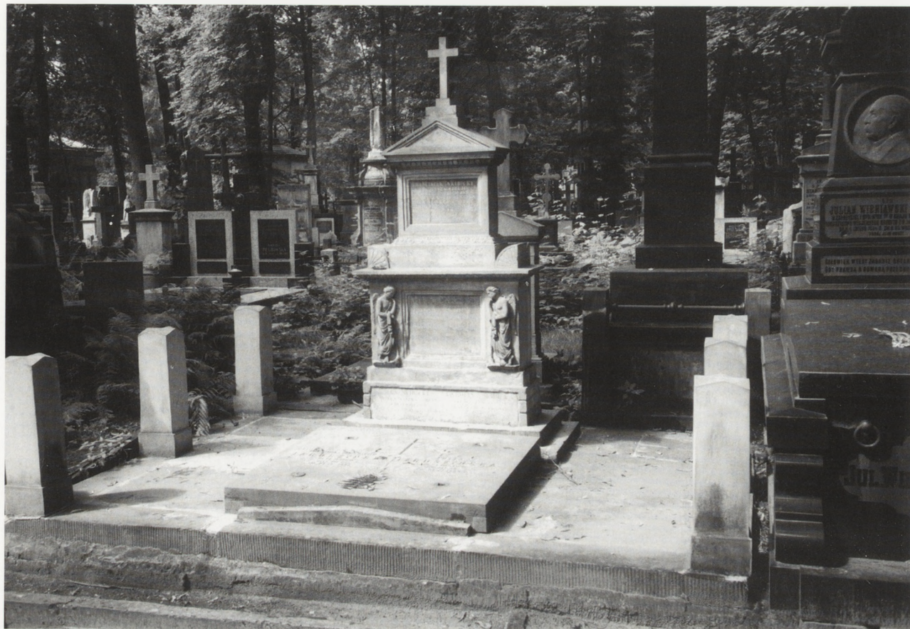
3. Pomnik nagrobny rodziny Skibickich z piaskowca drobnoziarnistego i wapienia zbitego — powtórnie zabezpieczony przed działaniem czynników atmosferycznych na drodze profilaktyki konserwatorskiej, strona południowo-zachodnia. Fot. W. Procyk
