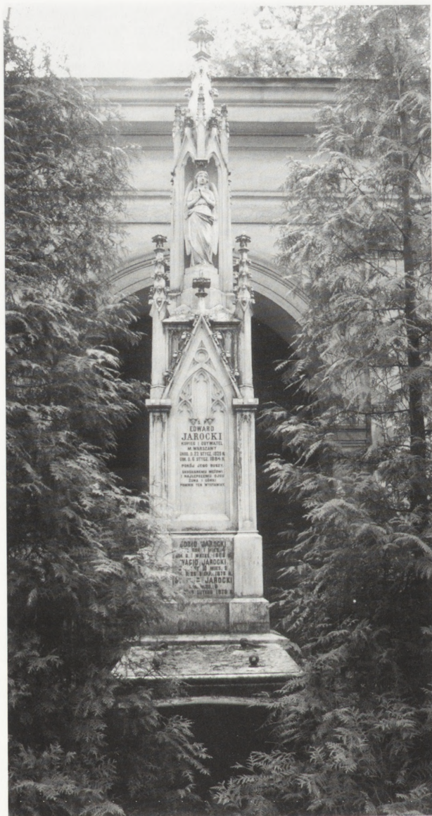
7a. Pomnik nagrobny rodziny Jarockich z marmuru karraryjskiego — w trakcie usuwania zanieczyszczeń pochodzenia atmosferycznego. Widok ogólny, strona północna. Fot. W. Procyk
