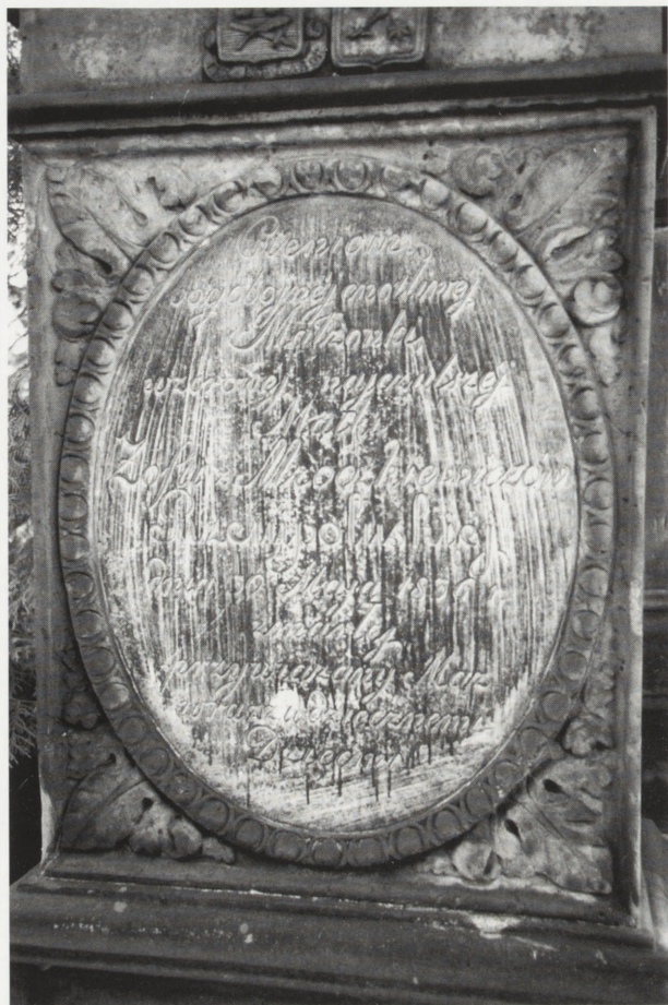
6a. Zmiany estetyczne na płycie epitafijnej z pomnika rodziny Rzempoluskich wywołane procesem wietrzenia powłoki zabezpieczającej z roztworu mikrowosku. Strona zachodnia — zbliżenie. Fot. W. Procyk
