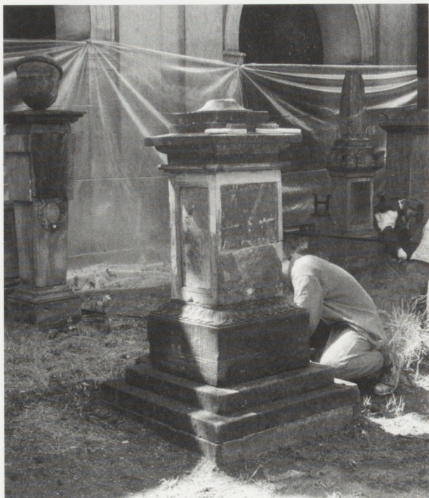
5a. Nagrobek rodziny Ulrichów z piaskowca i wapienia zbitego w trakcie usuwania zanieczyszczeń pochodzenia atmosferycznego, strona północno-wschodnia. Fot. W. Procyk
