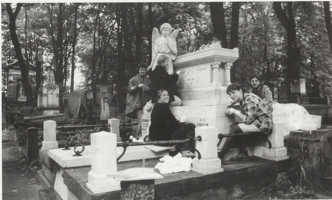
2. Pomnik nagrobny rodziny Biernackich z marmuru Carrara-Bianco po oczyszczeniu, w trakcie uzupełniania ubytków, wypełniania fug i szczelin wywołanych dezintegracją blokową, strona południowa. Fot. A. Zambrzycka
