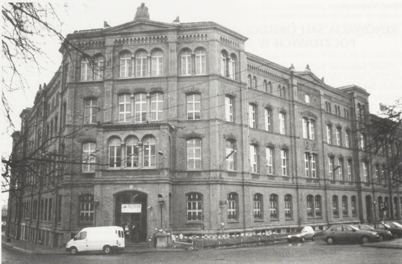
1. Budynek Urzędu Przewozu Poczty w Szczecinie przy ul. Dworcowej 20, elewacja od strony wejścia głównego dla klientów, stan z 2000 r. Fot. B. Makowska
