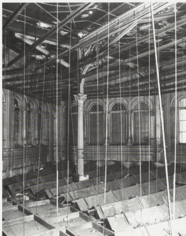
4. Fragment wnętrza sali obsługi interesantów poniżej historycznego świetlika; stan z 1975 r. Do stalowych szyn, opartych na belkach wktutych w ściany, podwieszony był wtórny strop; nieznacznie powyżej tego stropu wyraźnie widoczna granica, do której skuto wszystkie elementy pierwotnego wystroju. Fot. A. Smolny, neg. PKZ Szczecin
