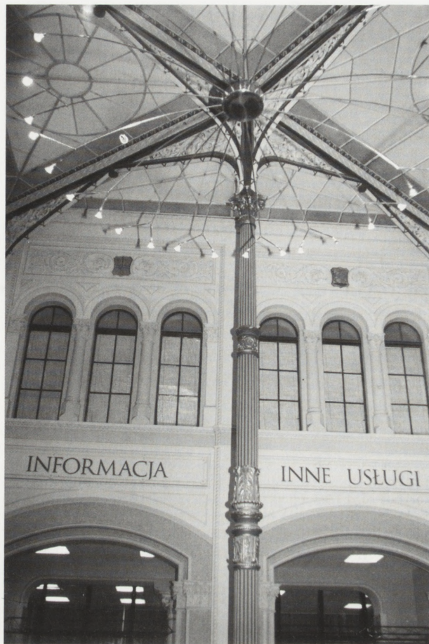
5. Wnętrze sali po przeprowadzonych pracach renowacyjnych i modernizacyjnych, stan w 2000 r. Fot. B. Makowska
