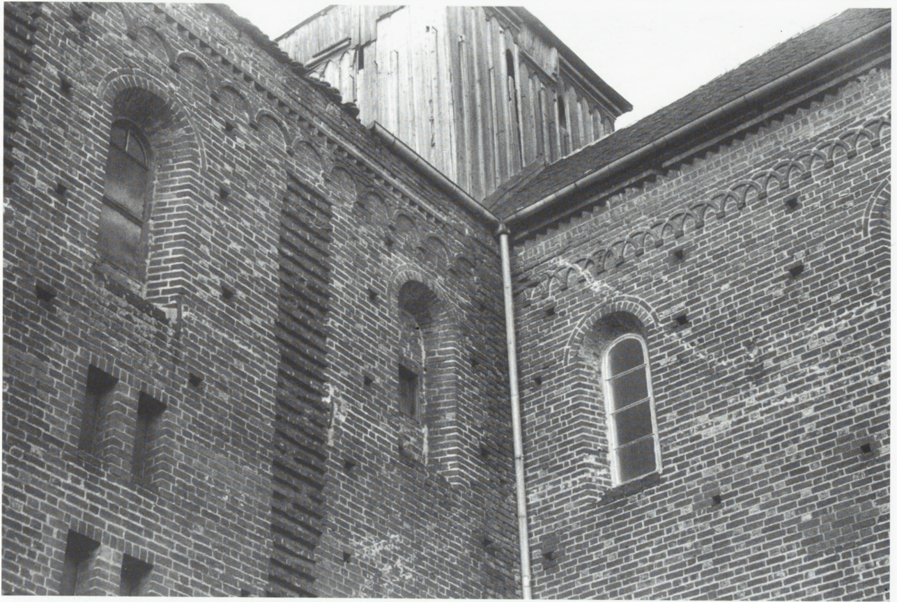
4. Kościół pocysterski w Kolbacz. Fragment zach. elewacji płd. ramienia transeptu (z widocznym fryzem z przenikających się arkadek) i płd. elewacji nawy głównej (z widocznym „prostym” fryzem arkadkowym). Stan z 1998 r. Fot. P. Dettloff
