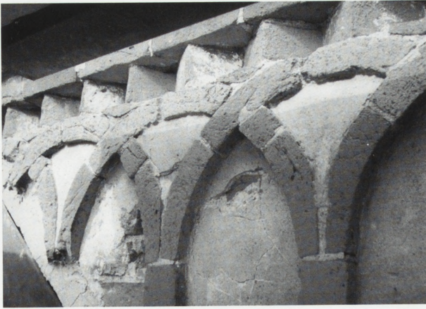
5. Kościół oo. cystersów w Mogile. Fragment fryzów: arkadkowego i zębatego pld. elewacji prezbiterium. Stan z 1999 r. (przed konserwacją). Fot. P. Dettloff
