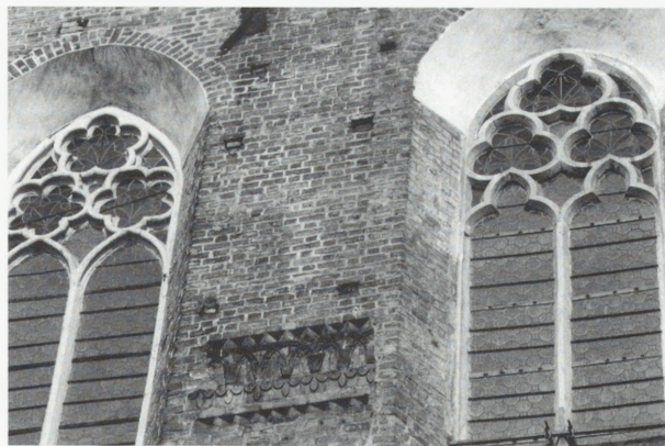
7. Kościół oo. dominikanów w Krakowie. Fragment płd. elewacji prezbiterium z widocznym fryzem arkadkowym ujętym fryzami zębatymi. Stan z 1998 r. (przed konserwacją). Fot. M. Szyma
