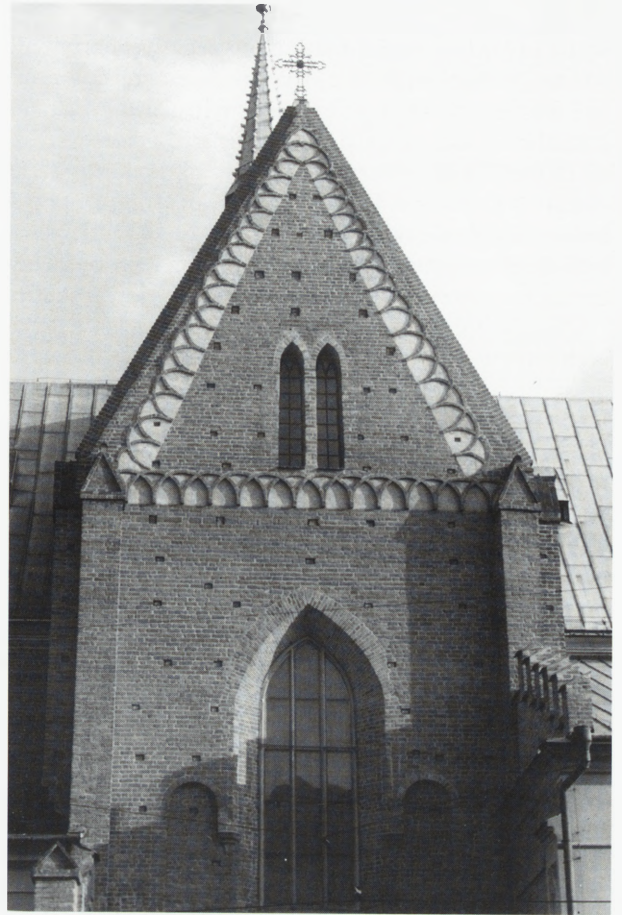
10. Kościół oo. franciszkanów w Krakowie. Fragment pln. elewacji pln. ramienia transeptu z fryzem arkadkowym. Stan z 2000 r. (po konserwacji). Fot. P. Dettloff
