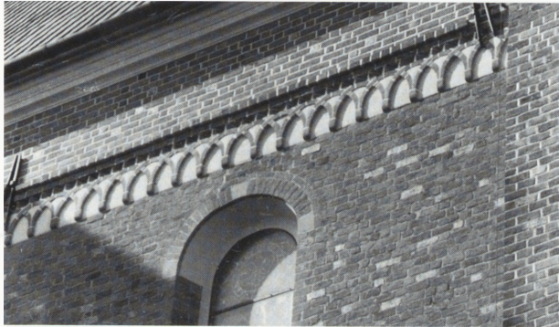
1. Kościół oo. cystersów w Mogile. Fragment pld. elewacji prezbiterium z widocznymi fryzami: arkadkowym i zębatym. Stan z 1999 r. Fot. P. Dettloff
