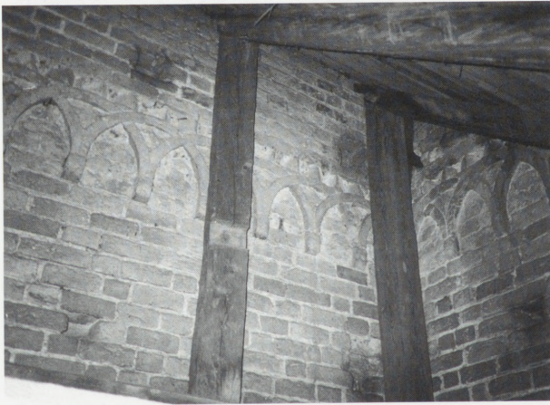
6. Kościół oo. cystersów w Mogile. Fragment fryzów: arkadkowego i zębatego wsch. elewacji pld. ramienia transeptu i pld. elewacji prezbiterium widoczny na strychu biblioteki. Stan z 1998 r. Fot. P. Dettloff
