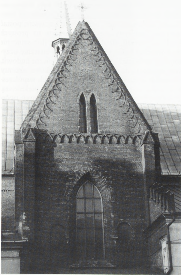
9. Kościół oo. franciszkanów w Krakowie. Fragment pln. elewacji pln. ramienia transeptu z fryzem arkadkowym. Stan z 1995 r. (przed konserwacją). Fot. T. Węclawowicz
