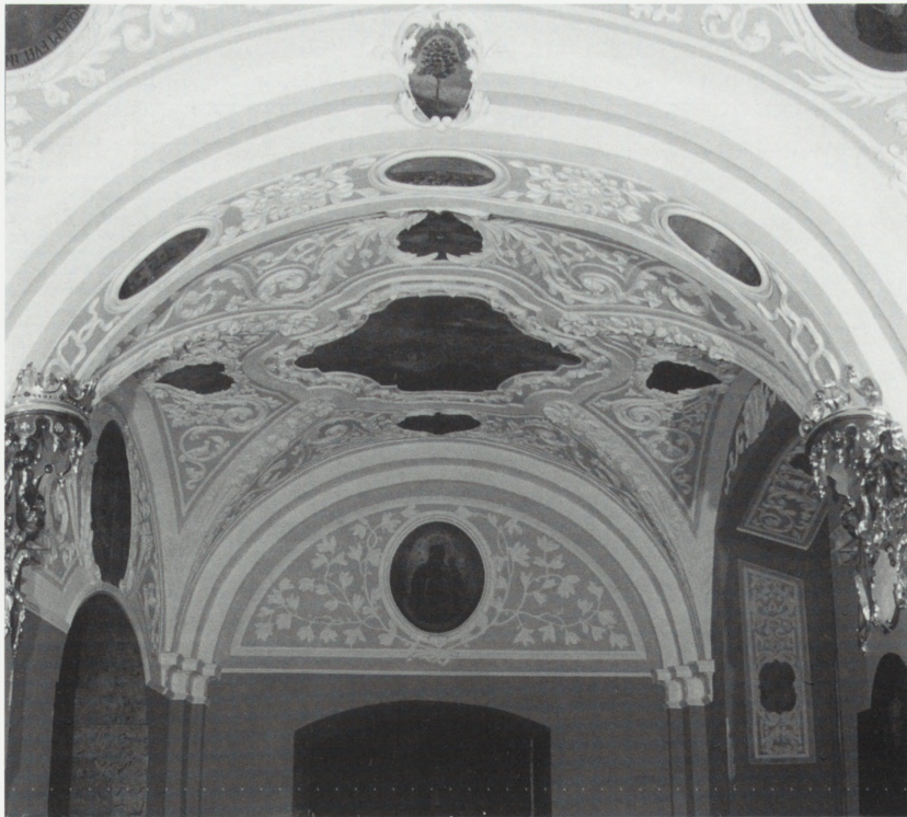
Poznań, kolegiata farna p.w. św. Stanisława bp., empora zachodnia po pracach konserwatorskich. Fot. J. Miecznikowski
