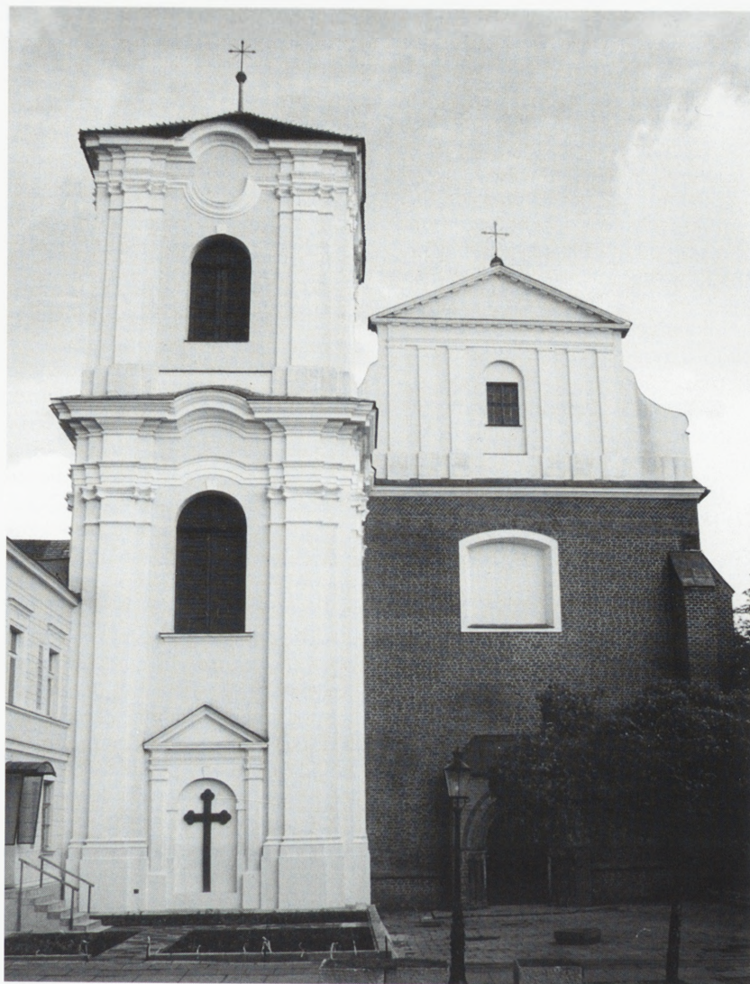
Poznań, kościół klasztorny jezuitów p.w. św. Najświętszego Serca Jezusowego i Matki Boskiej Pocieszenia, wieża po konserwacji. Fot. J. Miecznikowski
