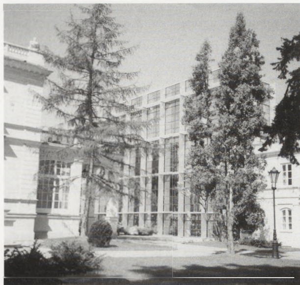
3. Pałacyk Sobańskich, Al. Ujazdowskie w Warszawie. Dążąc do jak najefektywniejszego ekonomicznie wykorzystania nieruchomości zabytkowej, inwestor zabudował część ogrodu przy rezydencji wielopiętrowym budynkiem biurowym. W rezultacie zabytkowy pałacyk został praktycznie pozbawiony otoczenia ogrodowego, które stanowiło integralną część zabytkowego założenia
