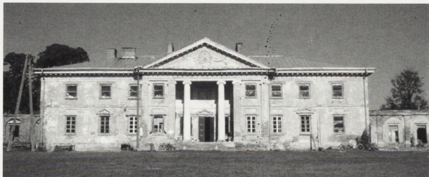
Korczew, pałac — w trakcie konserwacji. Fot. C. Ostas, 1997 r.
