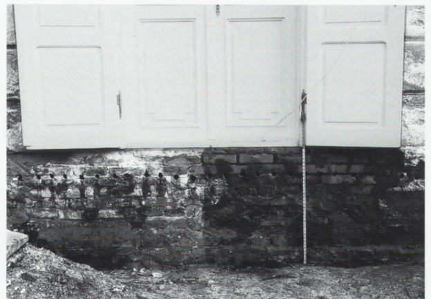
3. Wykonywanie izolacji metodą powłokowo-iniekcyjną. Fot. R. Gazda, 2000
