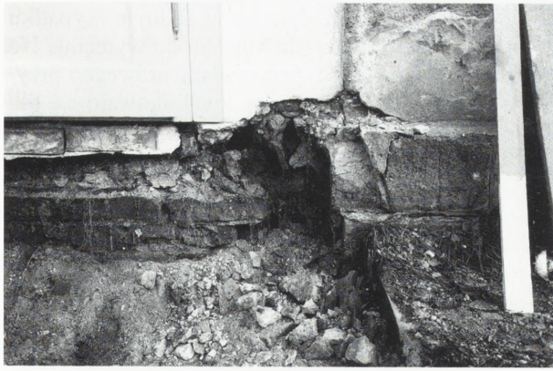
2. Fragment zewnętrznej ściany ośmiobocznego pomieszczenia dworu Mokronowskich w Jordanowicach – stan przed wykonaniem izolacji. Fot. R. Gazda, 2000
