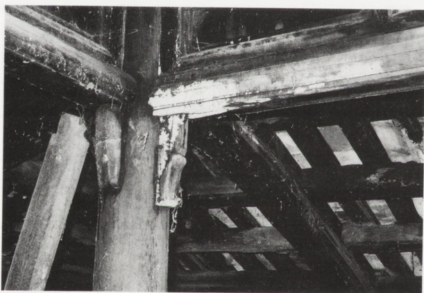
5. Owocnik grzyba Phlebiopsis gigantea na konstrukcji małego budynku koło świątyni The Mieu 5. Fructification of Phlebiopsis gigantea on the construction of a small building next to the The Mieu temple
