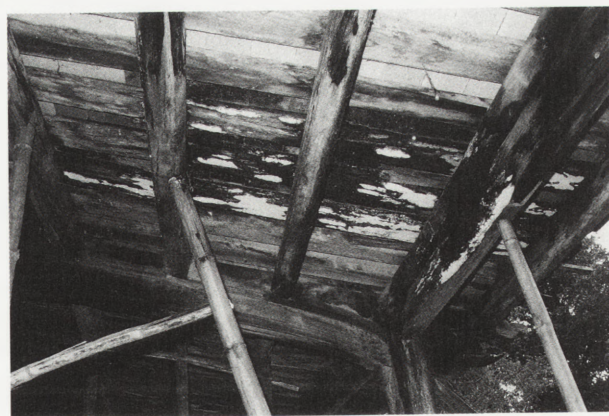
3. Spodnia część polaci dachu małego budynku koło świątyni The Mieu oprowadzona przez grzyb Poria medullaris
