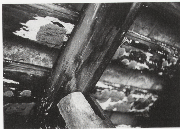
2. Fragment il. 1 z widocznymi owocnikami Serpula lacrymans
