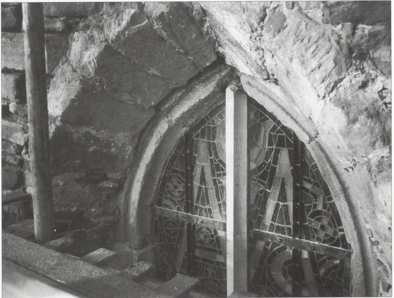
4. Jasło. Kościół parafialny, okno nawy od północy, odtworzenie pierwotnego kamiennego słupka. Fot. P. Szlezzynger 2002 r.
