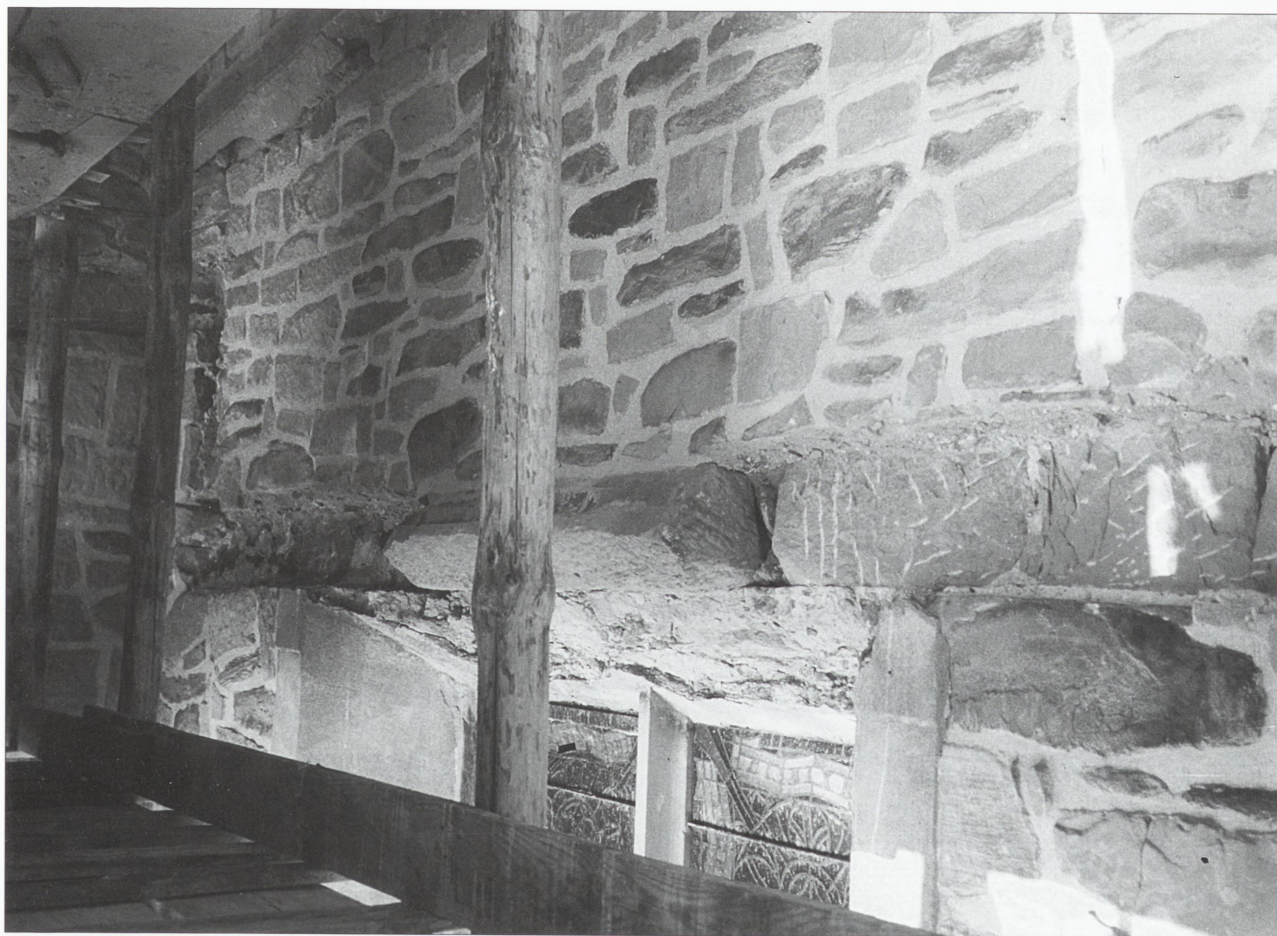
3. Jasło. Kościół parafialny. Okno nawy na elewacji południowej w trakcie prac konserwatorskich – odtwarzanie gzymsu okapnikowego, podokiennego, Fot. P. Szlezynger 2002 r.
