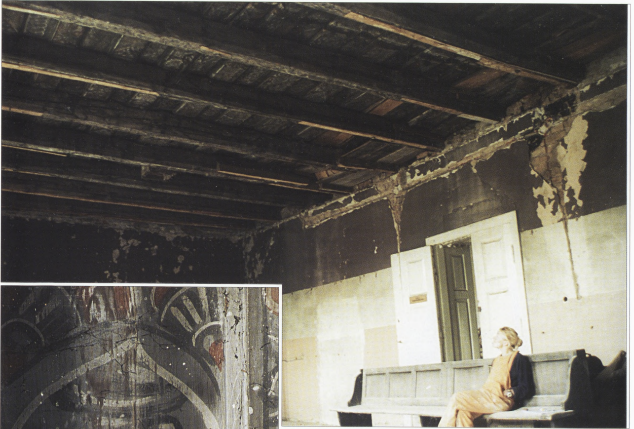
2. Wielka sala na pierwszym piętrze (w latach 70. sala kinowa) po usunięciu podsufitki zasłaniającej polichromowany strop 2. Great chamber on the first floor (in the 1970s a screening room) after the removal of a soffit ceiling concealing the polychrome vault
