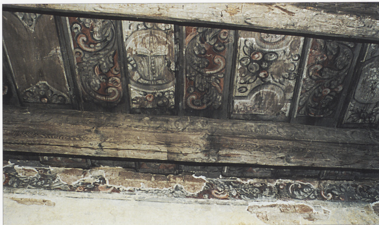
6. Wielka sala na pierwszym piętrze, odkryty polichromowany strop. Widoczny fryz na ścianie pn-wsch. 6. Great chamber on the first floor uncovered polychrome vault and visible frieze on the north-eastern wall
