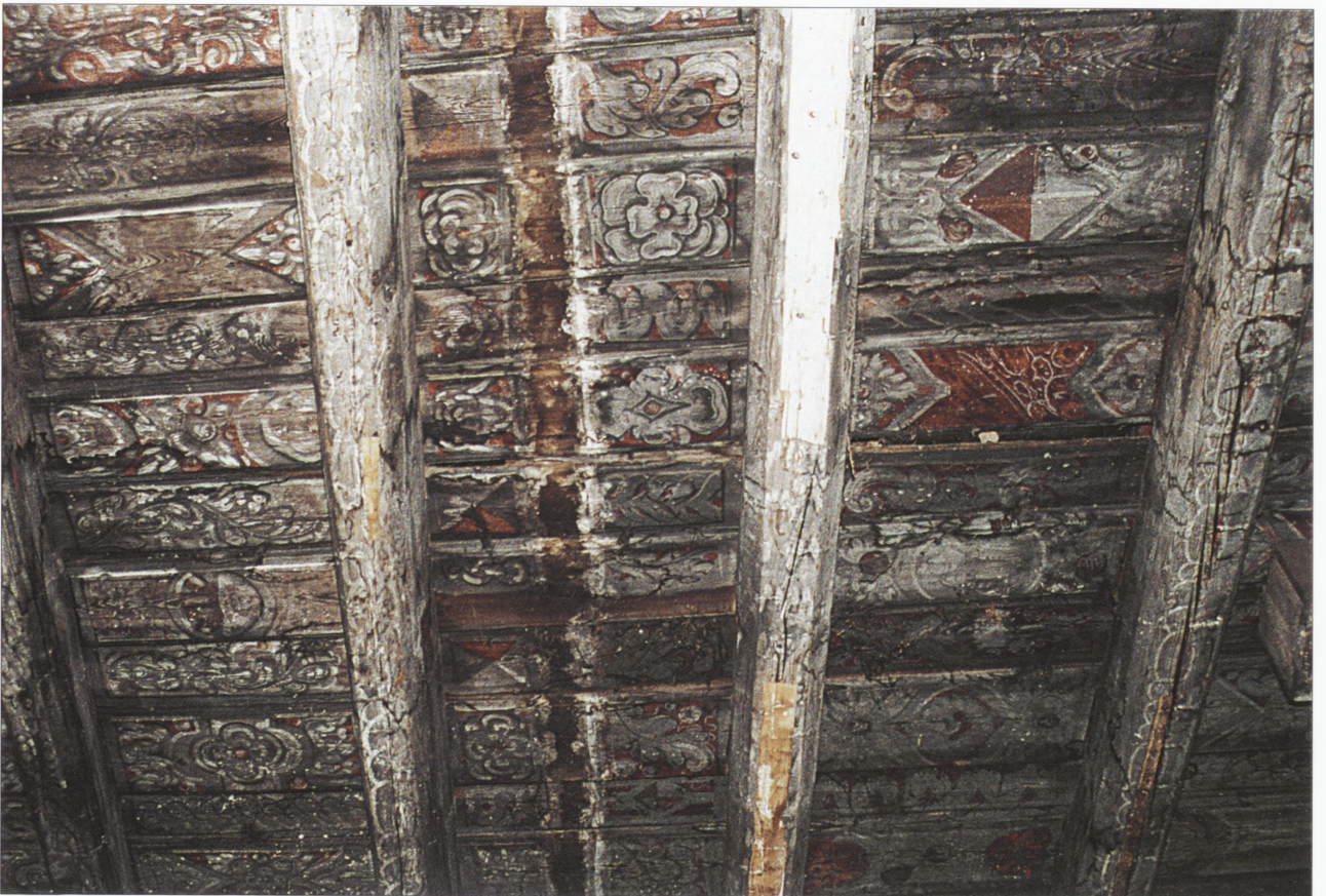
8. Wielka sala na pierwszym piętrze, odkryty polichromowany strop. Wszystkie zdjęcia P. Jakubowski 8. Great chamber on the first floor, uncovered polychrome vault. All photos by P. Jakubowski
