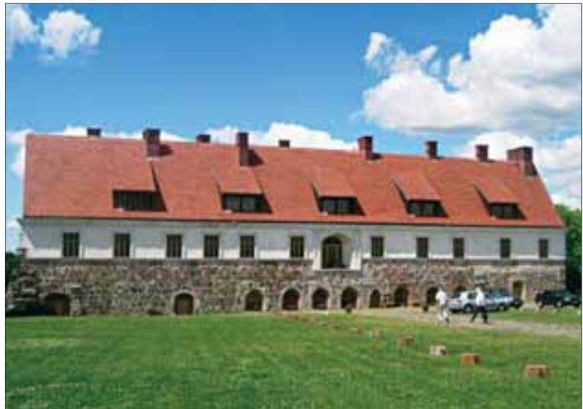
1. Zachodnie skrzydło klasztoru cysterek w Cedyni – odbudowane i zaadaptowane na cele hotelowe. Fot. W. Witek.
