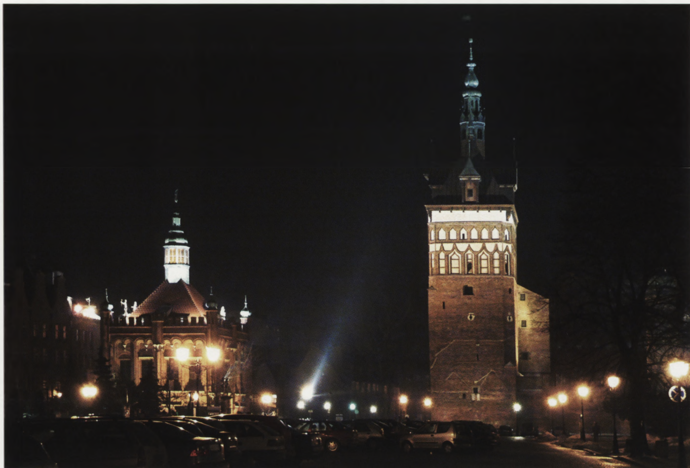
2. Gdańsk. Targ Węglowy, dominanta placu: Katownia z Wieżą Więzienną.
