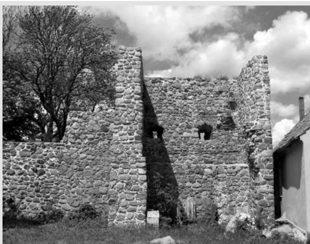
Ryc. 11. Czatownia typu marchijskiego (obiekt 26) z pozostałością murowanej klatki schodowej widoczną w prawym boku (fot. Marcin Czeszyk, stan z 2006 r. za: http://www.trzcinsko.com )
