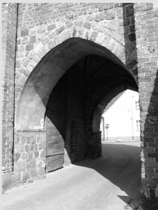
Ryc. 7. Przejazd Bramy Myśluborskiej z prowadnicą brony, drewnianymi wieżkami, kamiennymi konsolkami oraz sklepieniem krzyżowo-żebrowym (fot. autora, stan z 2009 r.)
