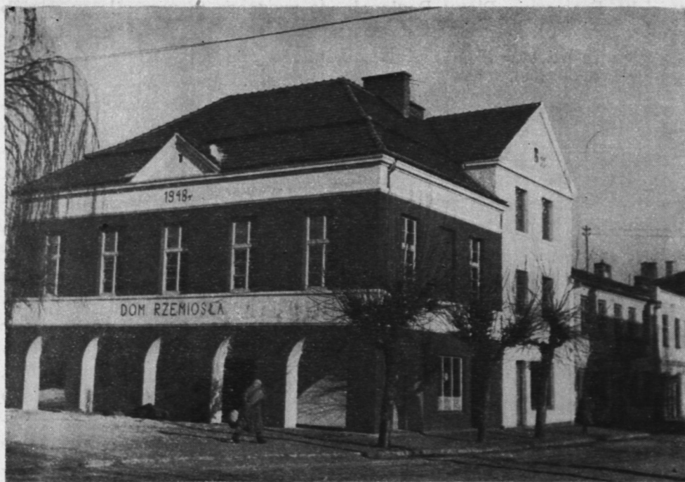
7. Odbudowany Dom Rzemiosła w Pułtusk
