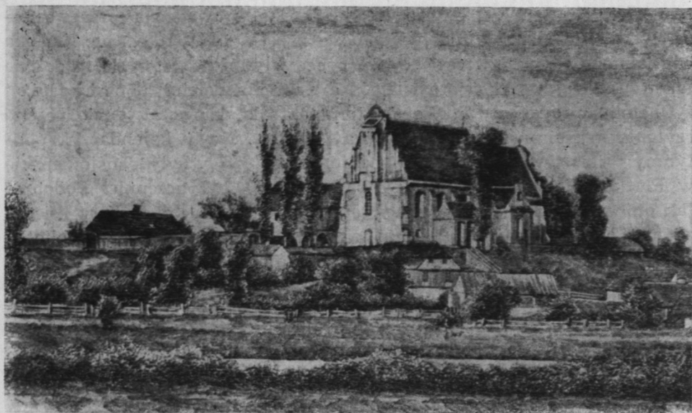
Ryc. 2. Sierpc, szkoła benedyktynek po lewej stronie w parterowym budynku drewnianym
