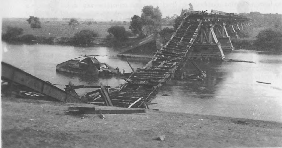
Fot. 1. Zniszczony most w Broku. Wrzesień 1939 r. (źródło: Internet)
