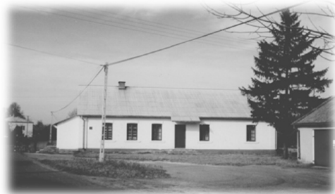
Budynek OSP dziś
