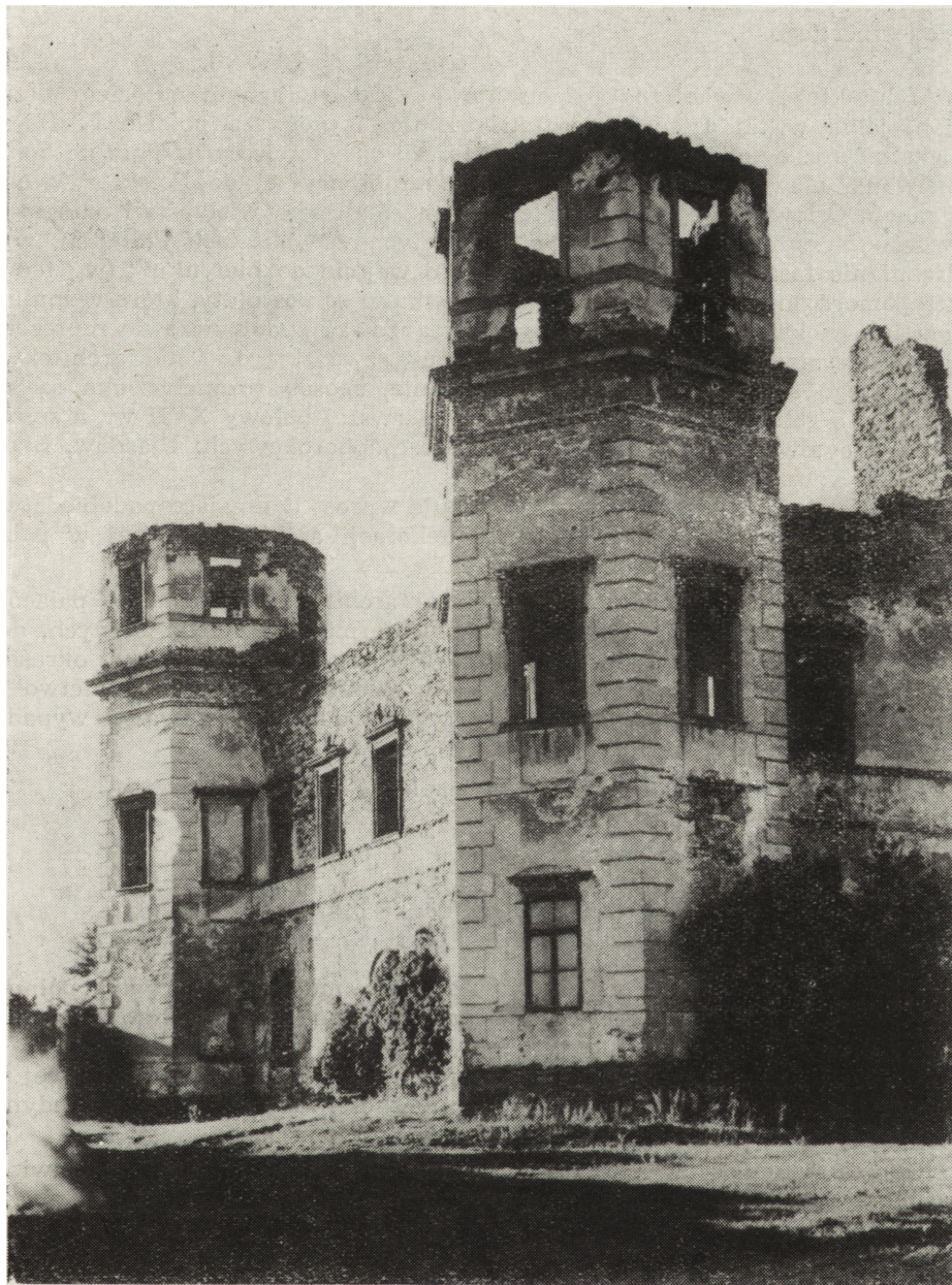
Ryc. 16. Podzamcze Piekoszowskie. Pałac. Widok od strony południowo-wschodniej
